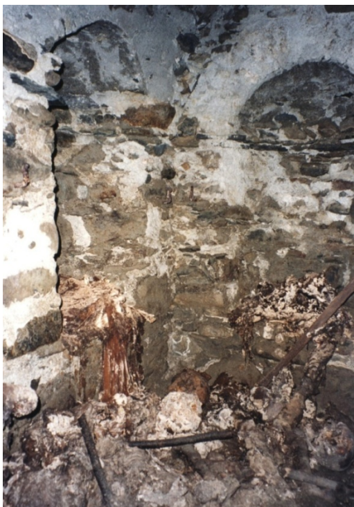
24 S. Stefano, cripta della chiesa, sedili colatoio.
