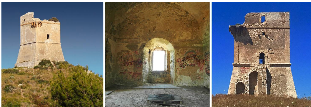
Fig. 7 - La 'Torre di Manfria' oggi.
