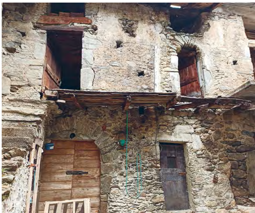
Figura 2. Polaggia, casa a corte: il piano sopraelevato sembra costruito in un secondo momento.
