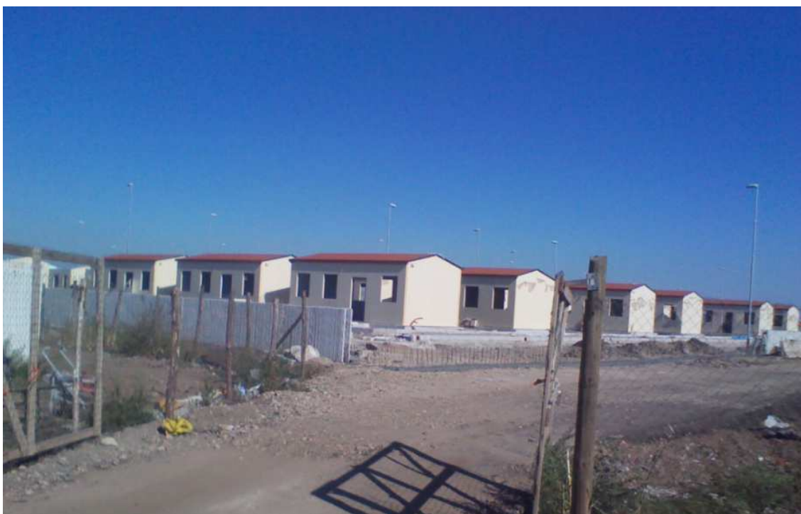
Figura 4 – Cantiere del nuovo villaggio attrezzato La Barbuta, Roma
