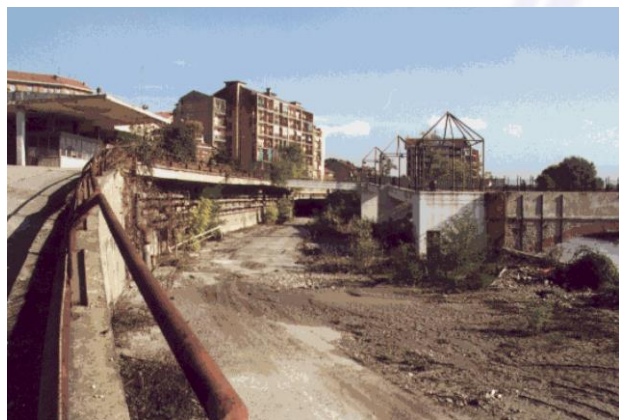
Fonte-Arpa Piemonte-Agenzia Regionale per la Protezione Ambientale del Piemonte-Sponda sinistra del fiume Dora Riparia con l'imbocco del tunnel ferroviario in disuso
