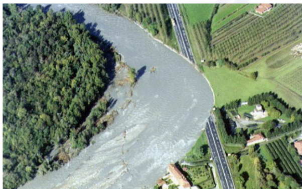
Arpa Piemonte-Agenzia Regionale per la Protezione Ambientale del Piemonte-Tangenziale di Pinerolo
