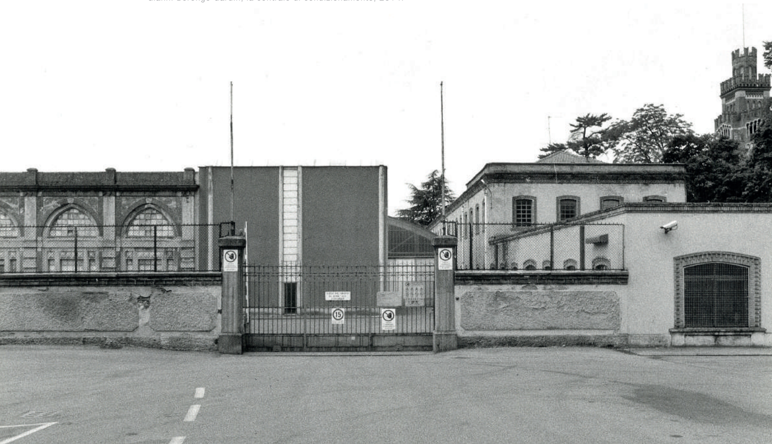
Gianni Berengo Gardin, la centrale di condizionamento, 2014.
