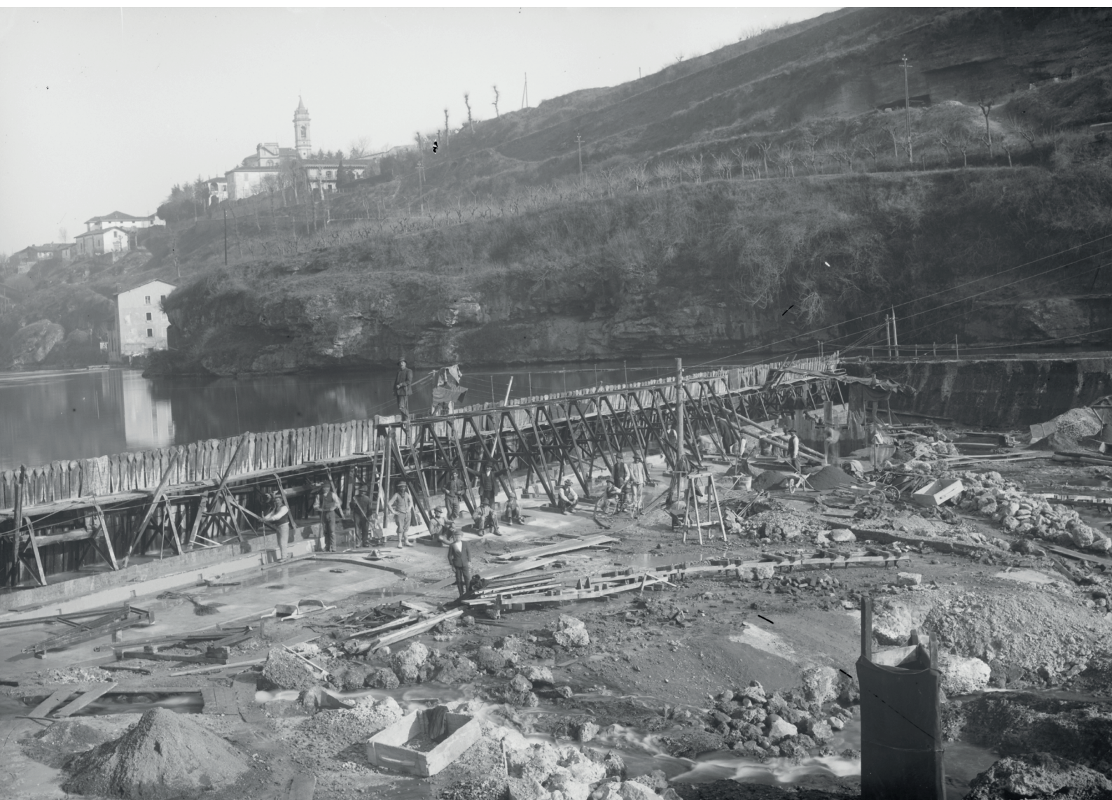
Crespi d'Adda. Realizzazione del canale di carico della centrale idroelettrica, fine '800
