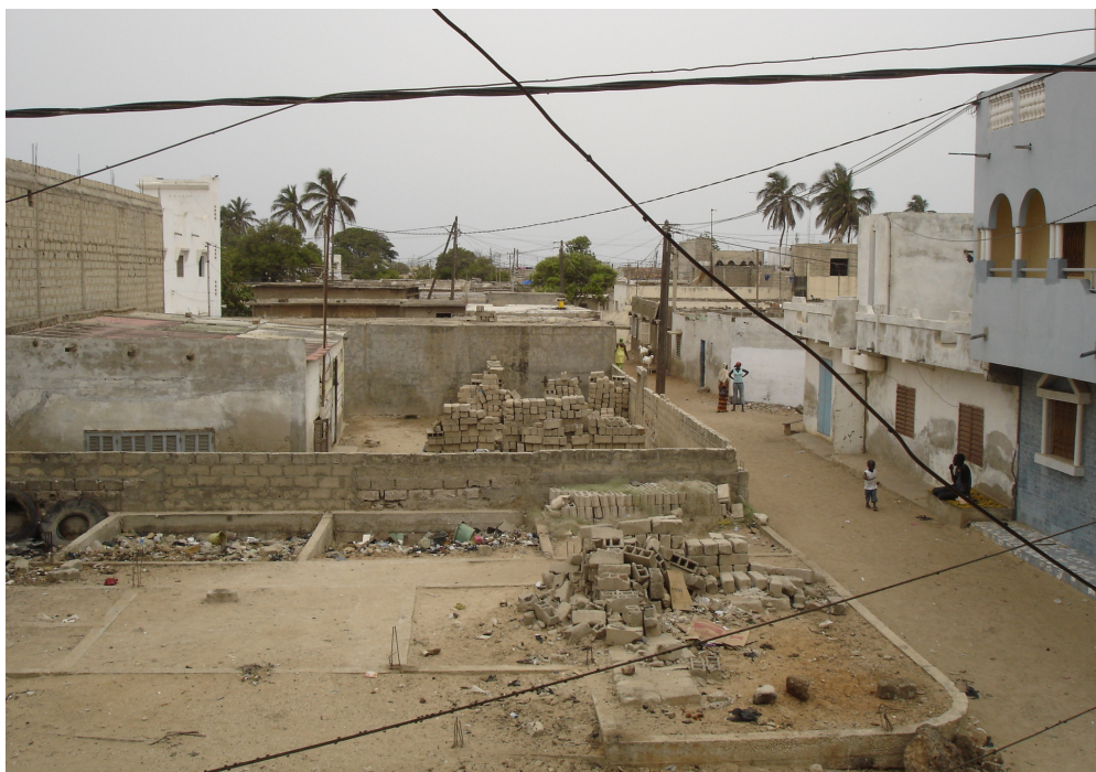
Fig. III – Edifici in costruzione a Thiaroye-sur-Mer.
