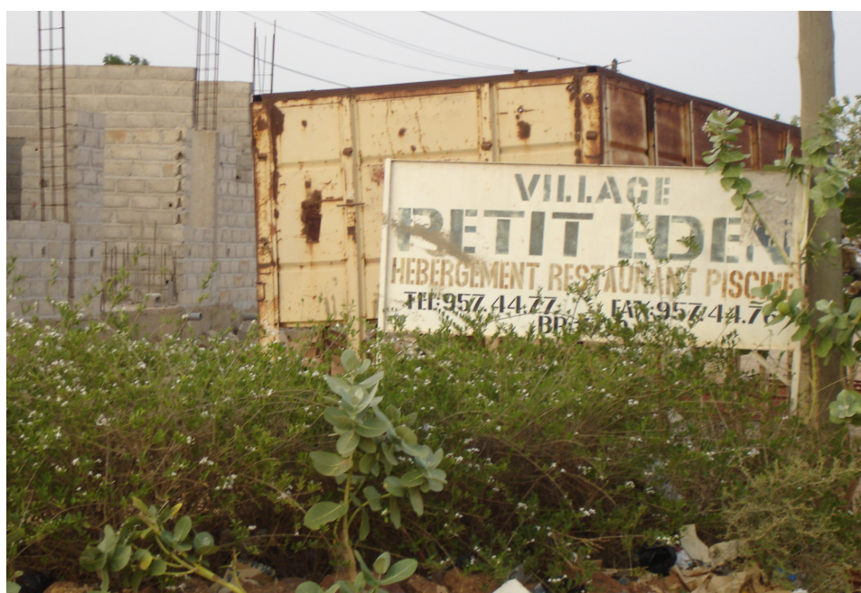
Fig. XXXII - 'Petit Eden' Struttura alberghiera con piscina e ristorante in costruzione situato sulla direttrice stradale che separa il quartiere di GranBour da quello di Chateau d'Eau.
