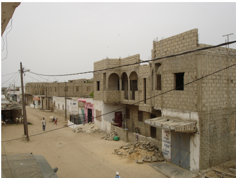
Fig. IV - Edifici in costruzione a Thiaroye-sur-Mer.
