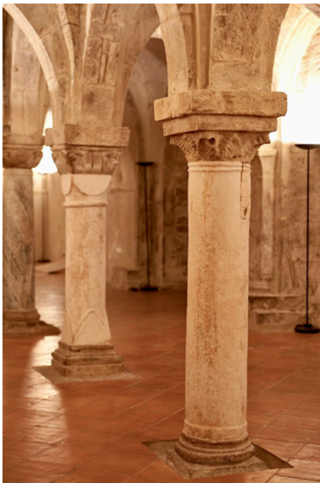
9 Guglionesi, Santa Maria Maggiore, cripta di Sant'Adamo, particolare dei sostegni (F. Gangemi)
