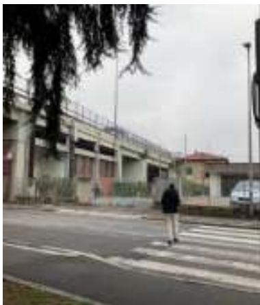
Figura 47: Via di accesso al centro di culto, via Rosa.
