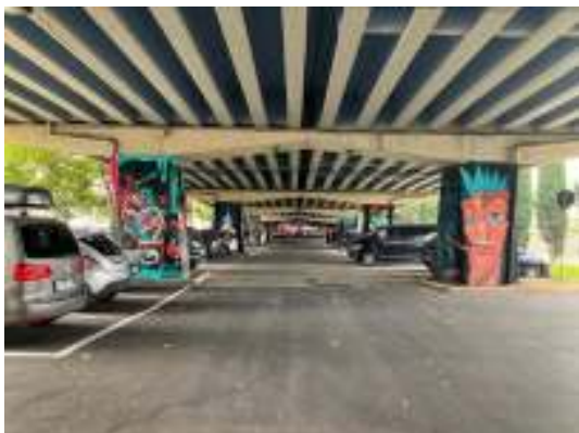
Figura 57: Viadotto di Via Boccaleone.
