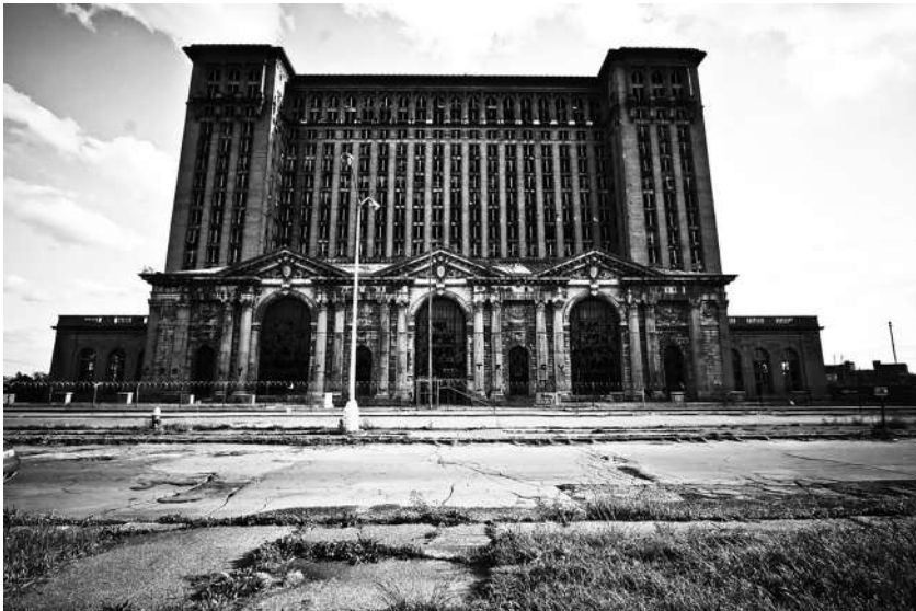
Imagen 1. Michigan Central Station (imagen de Flickr por Kate Sumbler, via Creative Commons)
