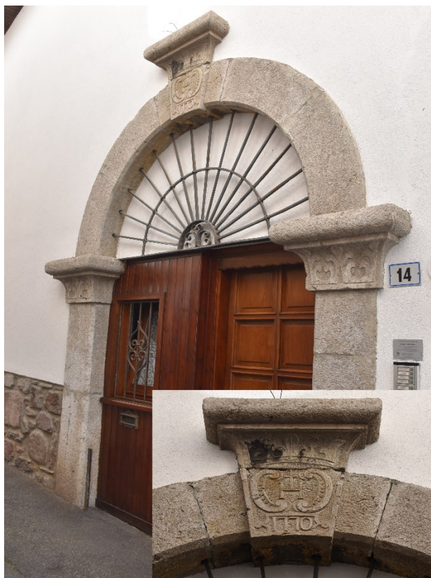
Figura 12 – Il portale del forno nuovo, recante la data di realizzazione 1770, è stato riconvertito in portone d'ingresso dei nuovi appartamenti, venendo, a detta di alcuni abitanti, sconsideratamente abbassato. Si tratta dell'unica testimonianza dell'antico forno (foto dell'autore).
