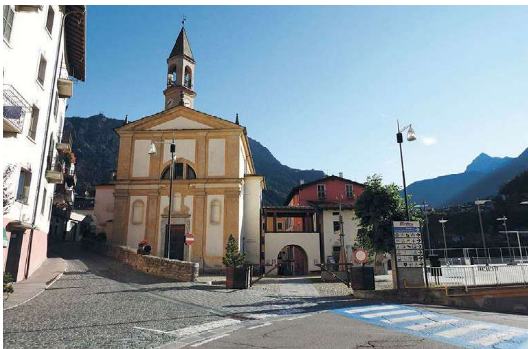
Figura 27. Via Milano a Chiesa in Valmalenco, lastricata con cubetti di serpentinoscisto.
