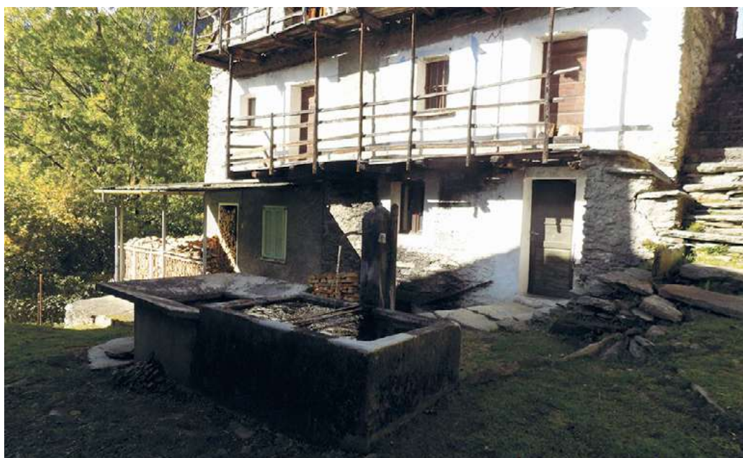
Figura 56. La fontana di recente costruzione in cemento al centro della piazzetta a Scaia è abbinata a un lavatoio.
