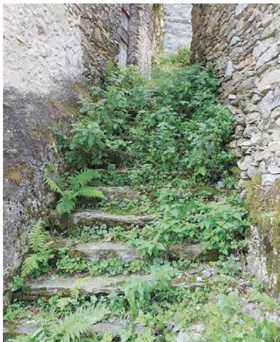
Figura 22. Strada interna a Cagnoletti. L'esposizione a nord favorisce la crescita di una flora sciafila.
