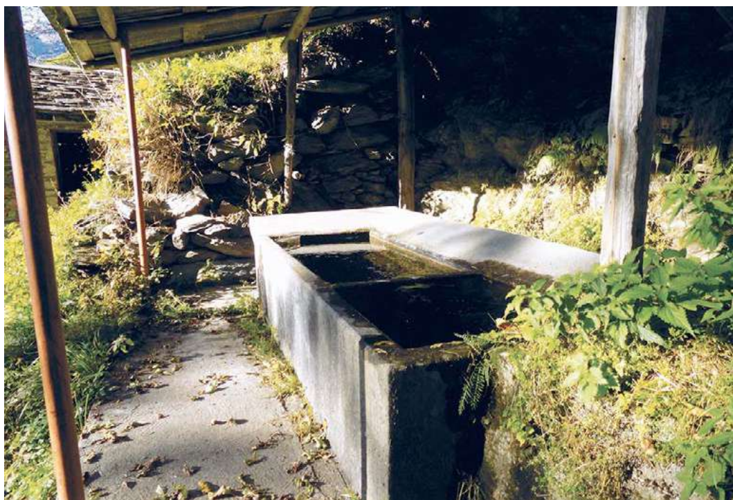
Figura 74. Nella frazione Gianni il lavatoio è inserito in una nicchia del pendio, la cui parete è protetta da un muro di sostegno colonizzato da un consorzio vegetale complesso.
