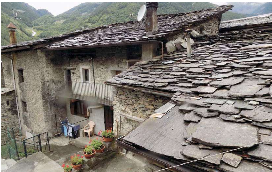
Figura 31. Particolare di una copertura in Ciatum de tèc di una casa a Cagni. Le differenze pezzature delle lastre e l'asimmetria della posa rende unica ogni copertura con queste pietre.
