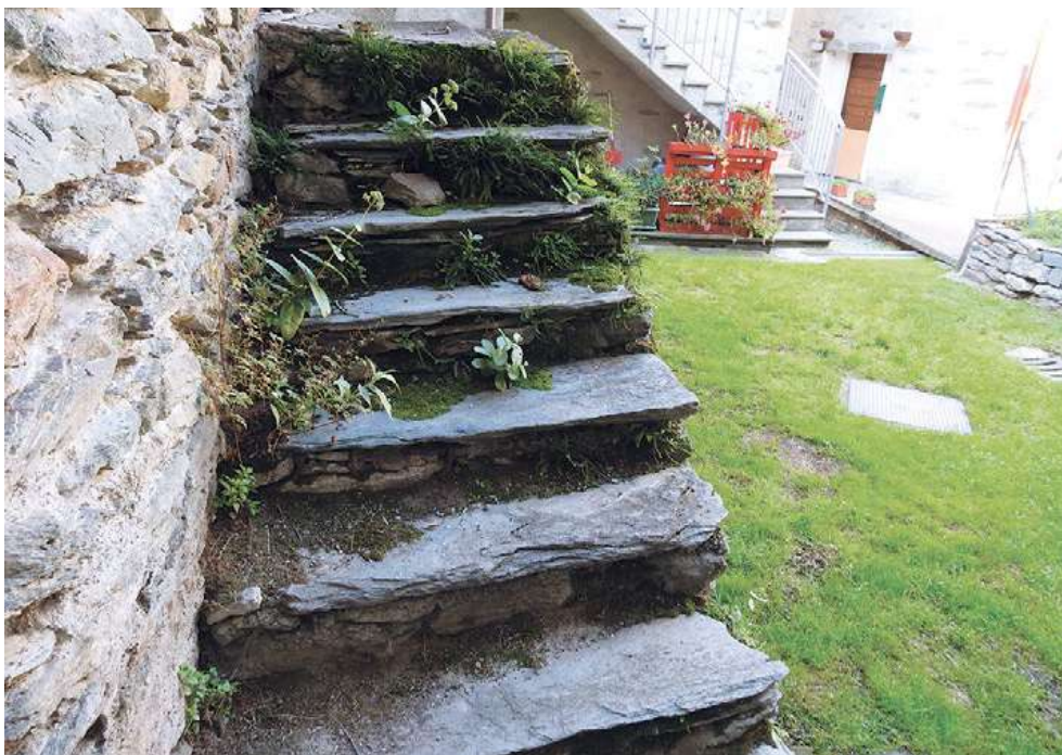
Figura 52. Scala in pietra a Vassalini. La Vegetazione, composta da Borracina maggiore, Asplenio tricomane e Geranio di San Roberto colonizzano preferibilmente il limite tra la pedata e l'alzata dei gradini e i bordi con la parete della casa, dove minore è il calpestio.
