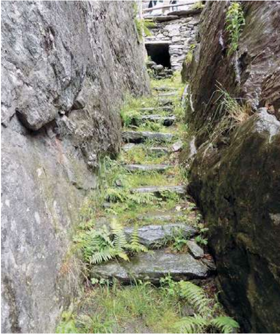
Figura 19. Strada interna alla contrada Scilironi.
