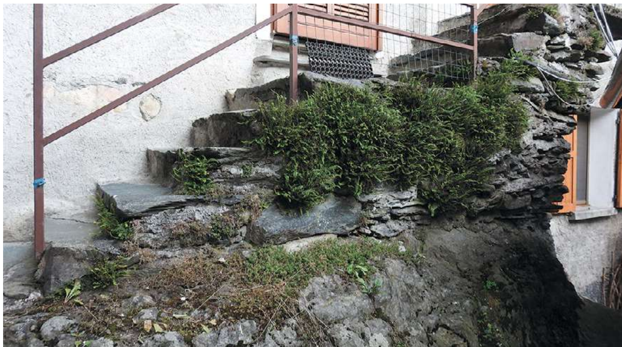
Figura 48. A Vetto la rampa delle scale si giova di un grosso masso addossato alla parete della casa. Tra un clasto e l'altro si è insediata una ricca flora dominata dalla felce Asplenio tricomanes .
