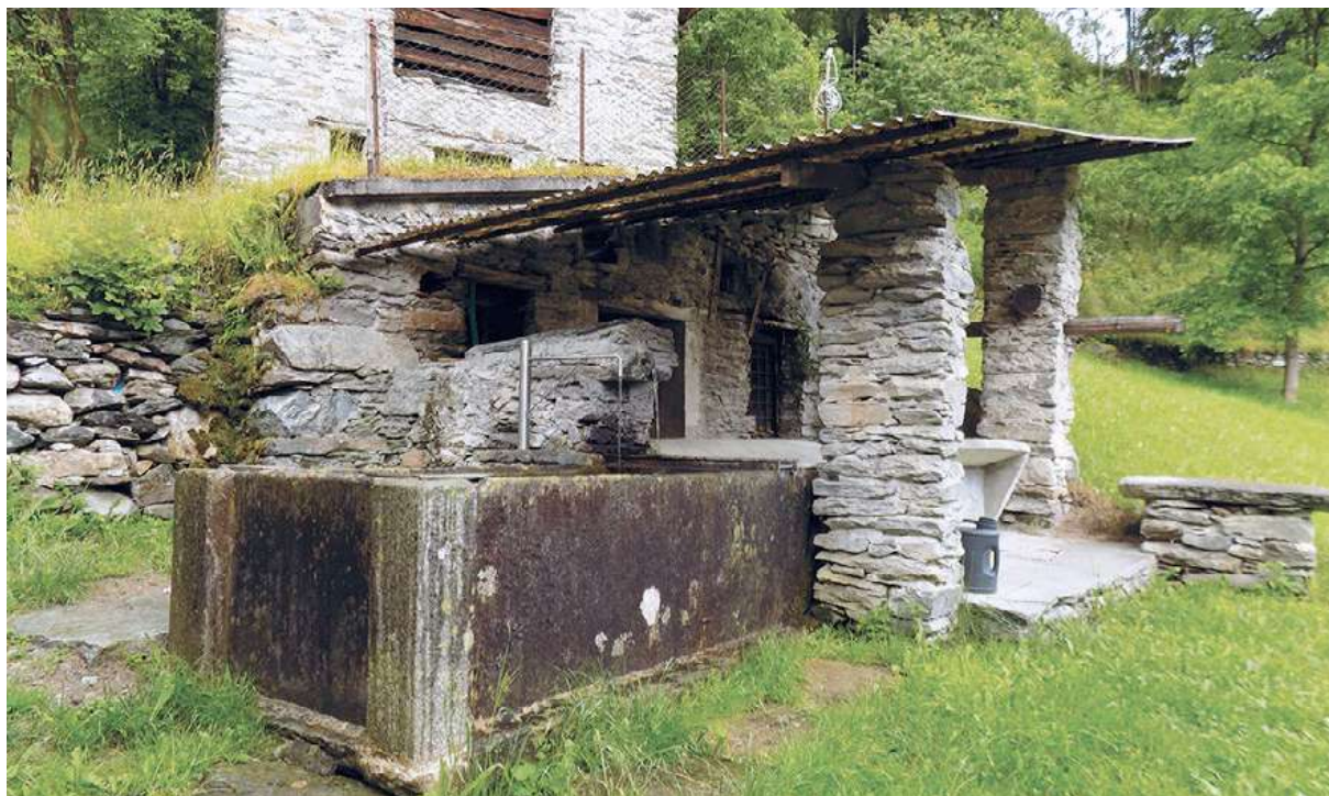
Figura 57. La fontana a Zarri è abbinata al lavatoio protetto da una tettoia. La vasca della fontana è realizzata dall'assemblaggio di lastre e blocchi di pietra, tenute insieme da incastri o graffe in ferro.
