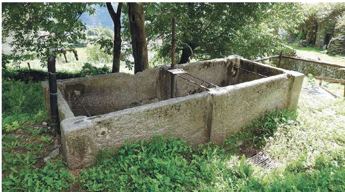
Figura 58. Fontana nell'antico borgo abbandonato di Cagnoletti. Una vegetazione ruderale circonda la vasca in lastre e blocchi di pietra.
