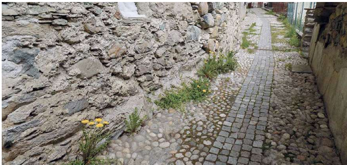
Figura 15. Strada interna a Primolo pavimentata in ciottoli con striscia centrale in cubetti di serpentinoscisto. La vegetazione dai bordi, dove minore è la pressione da caelestio, si protende verso il centro della via.
