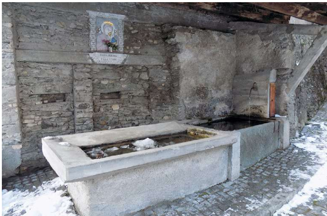
Figura 55. Fontana con la vasca in pietra a Tornadri, abbinata ad un lavatoio di recente costruzione in cemento.
