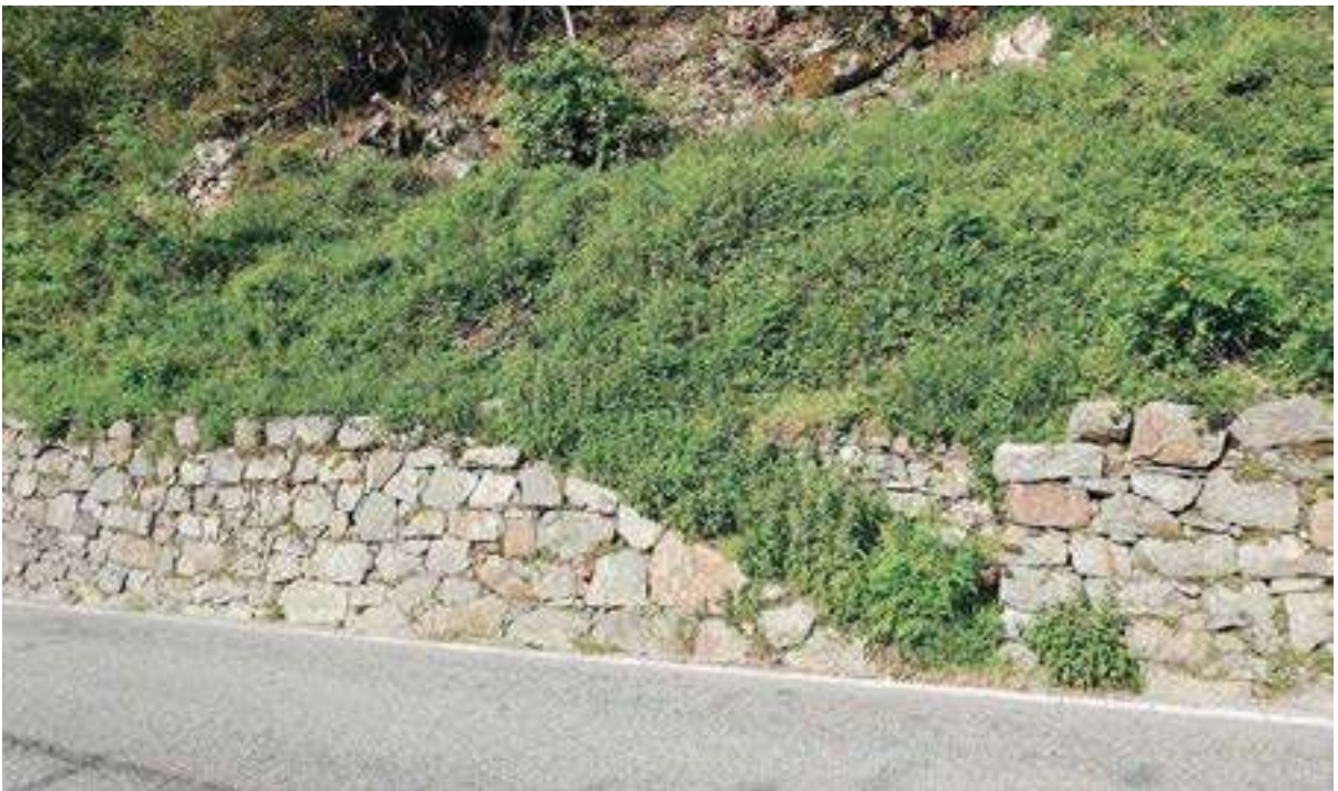
Figura 45. Scala di accesso ai terrazzamenti in località Gualtieri. Una ricca flora nitrofila ha ricoperto completamente le pietre della scala.
