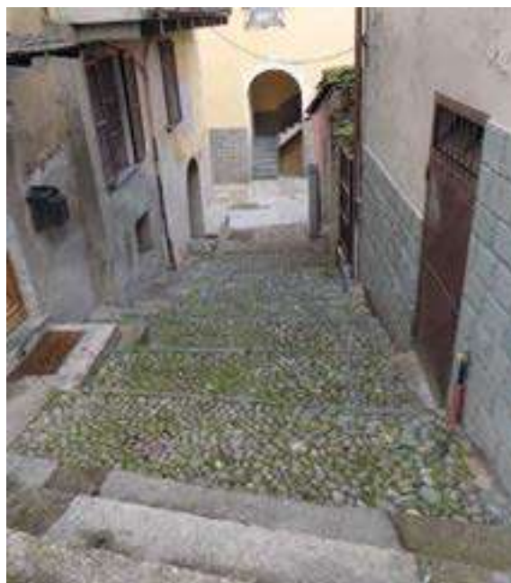
Figura 25. Rampe di scale in acciottolato a Chiesa in Valmalenco.
