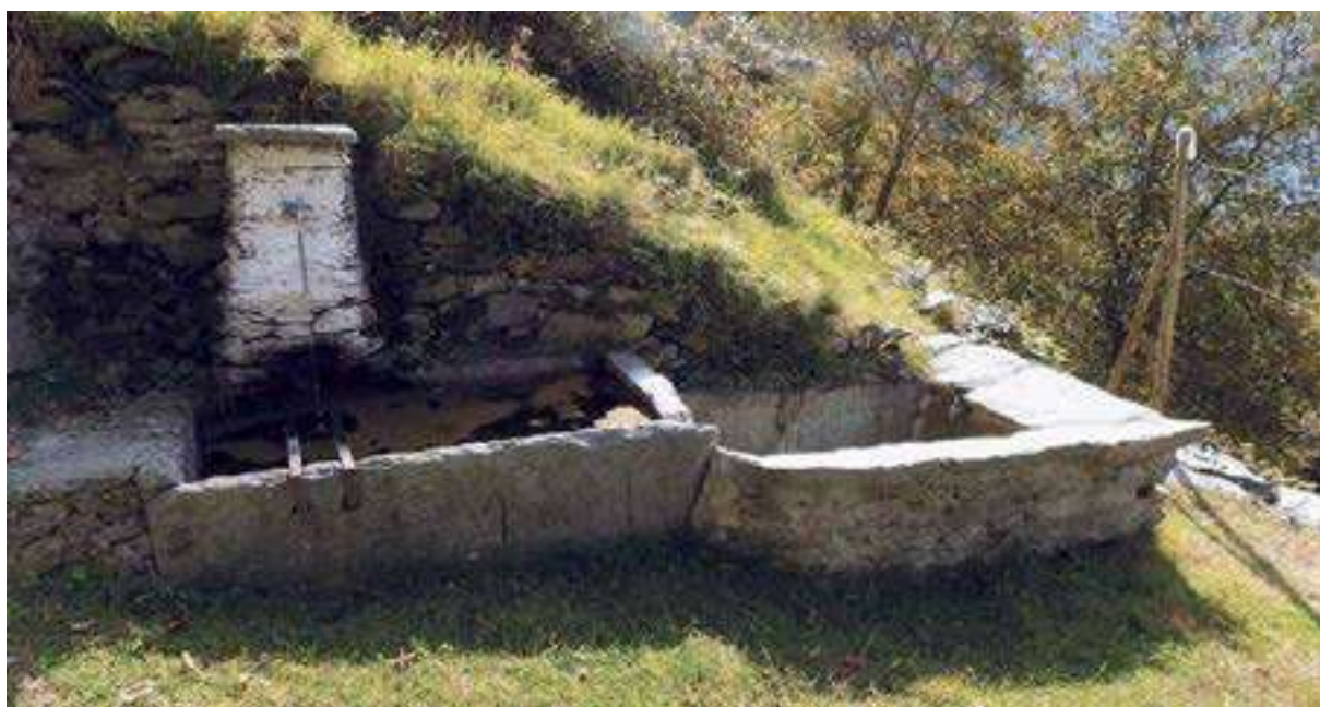
Figura 66. I lavatoi erano spesso abbinati ad una fontana di cui utilizzavano l'acqua di scolo. Un esempio è il lavatoio a Bedoglio con piani inclinati in pietra. Il muro su cui si appoggiano la fontana e il lavatoio ospita un'interessante flora rupicola.
