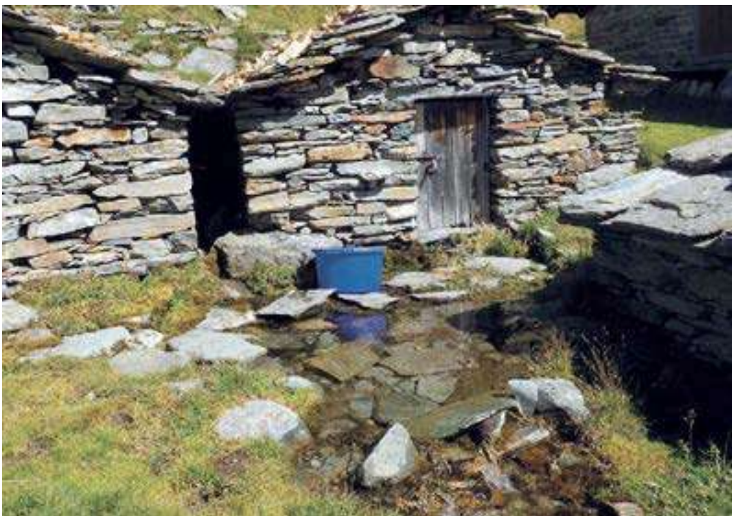
Figura 48. All'uscita del casello del latte l'acqua defluisce verso il ruscello a valle.
