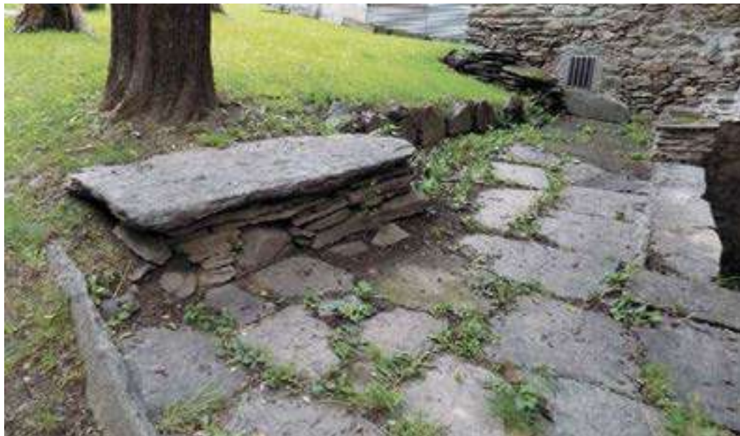
Figura 8. Piccola piazzetta in località Cristini pavimentata con lastre di serpentinoscio. Nelle linee di fuga trovano spazio essenze tipiche dei calpestii.
