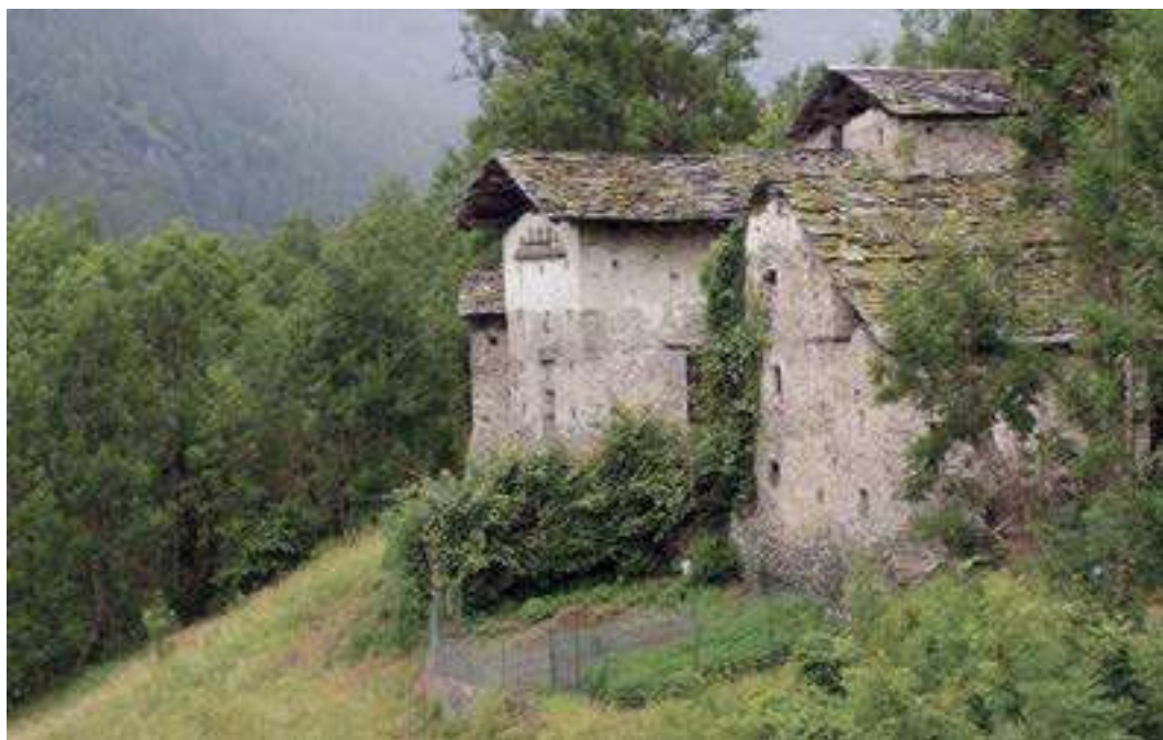
Figura 38. I tetti dell'antico insediamento di Melirolò sono ricoperti dall'indistruttibile Ciatum de tèc colonizzati da un consorzio vegetale peculiare.
