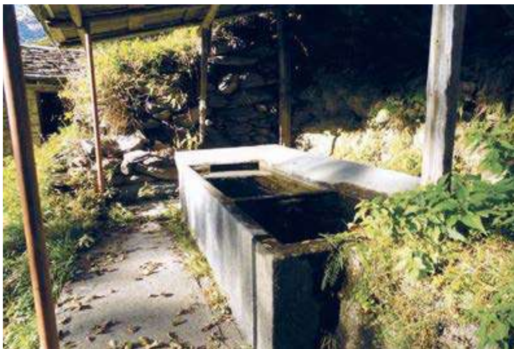
Figura 74. Nella frazione Gianni il lavatoio è inserito in una nicchia del pendio, la cui parete è protetta da un muro di sostegno colonizzato da un consorzio vegetale complesso.
