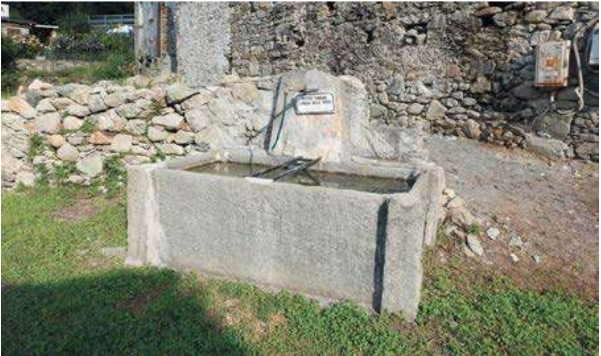
Figura 59. Fontana con la vasca in pietra a Galtieri. Il fondo attorno alla fontana è in terra battuta, colonizzato dalla vegetazione dei prati e dei calpestii.
