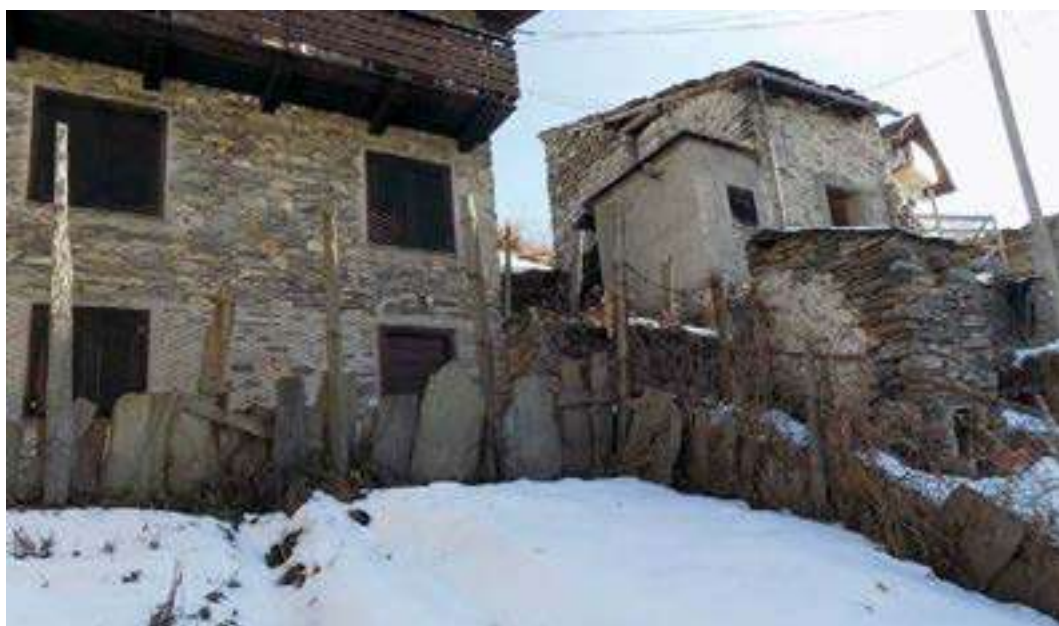
Figura 29. Recinzione di un orto a Pedrotti con pali di serpentinoscisto. Lungo il perimetro dell'orto sono state collocate in verticale lastre in pietra a protezione termica delle colture orticole.
