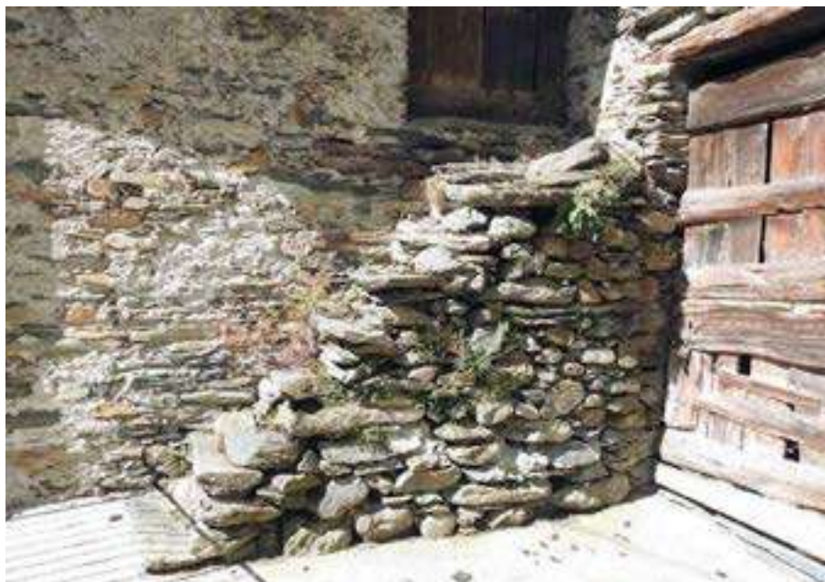
Figura 2. Dettaglio dell'accesso rialzato ad un'abitazione realizzato utilizzando elementi di provenienza detritica, fluviale o glaciale, come suggerisce la forma e l'irregolarità degli elementi, che si riflette sulla tessitura muraria. Le pedate sono realizzate con elementi monolitici planari, lisci ma al contempo scabri per la sicurezza di chi sale o scende le scale.
