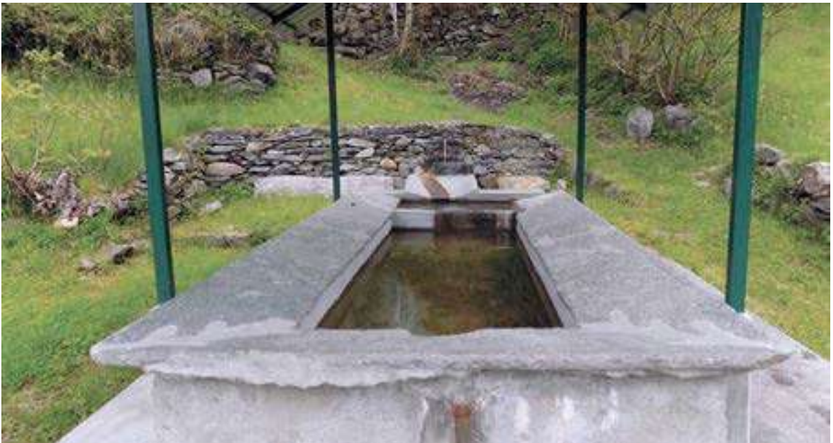
Figura 68. Lavatoio con piani inclinati in pietra al riparo di una tettoia a Cagnoletti.
