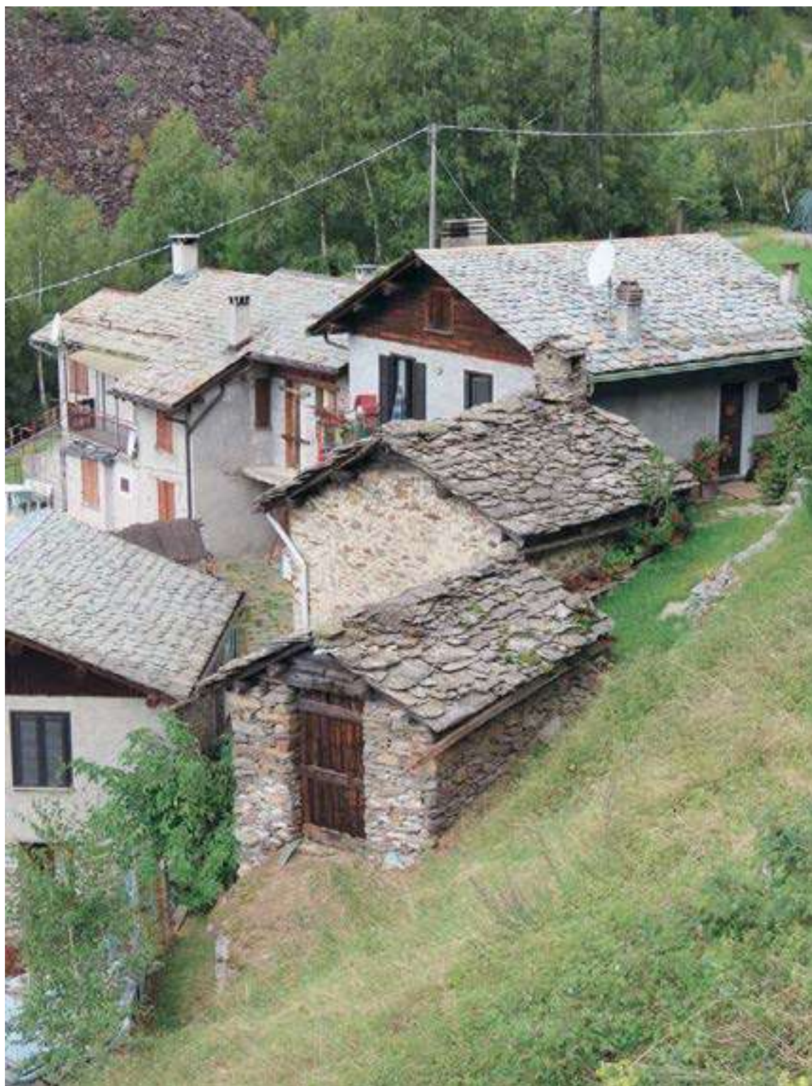
Figura 7. La “monocultura minerale” dei tetti in pietra della Valmalenco, in un piccolo agglomerato di case con il manto di copertura dei tetti dal tipico aspetto a squame. Si notino i tetti più recenti, in serpentinoscisto, a bassissimo spessore, e quelli più antichi, più spessi e ancora performanti.
