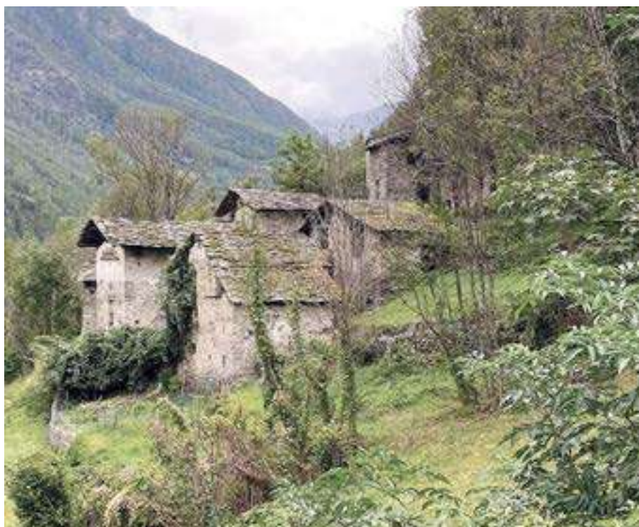
Figura 21. Vista d’insieme dell’agglomerato di costruzioni di Melirolo dal sentiero che parte da Cristini.
