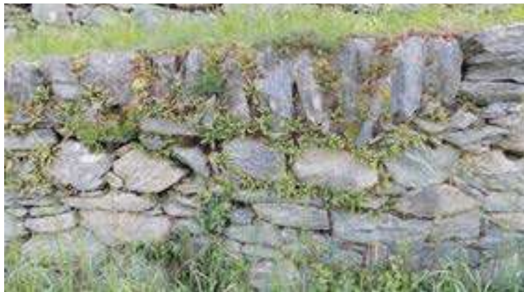
Figura 15. Muro di sostegno di un terrazzamento a vite a Cagnoletti. I massi alla sommità sono posati con perizia a coltello e ospitano tra gli interstizi numerose piante della piccola felce Cedracca comune.
