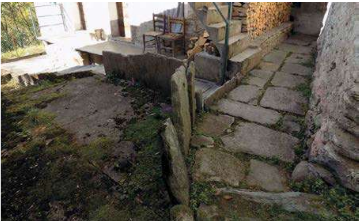
Figura 25. Lastre in pietra in verticale delimitano proprietà e passaggi pedonali all'interno del centro abitato di Scaia.
