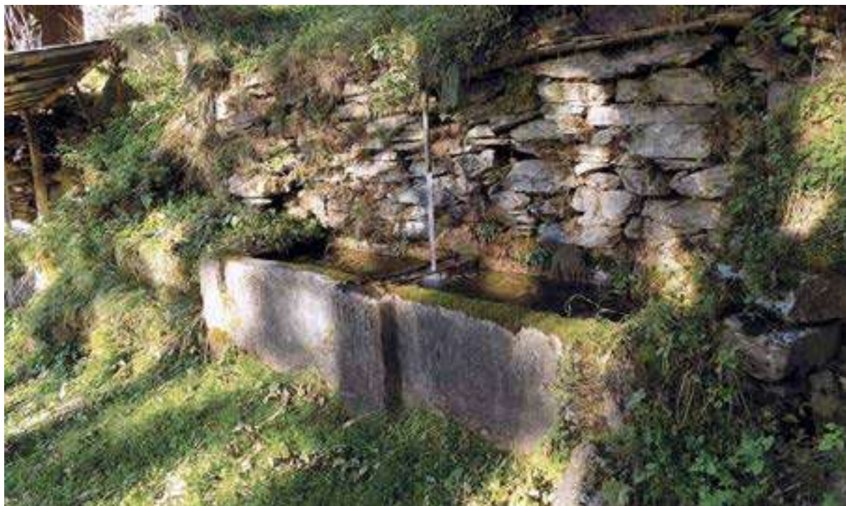
Figura 61. La fontana a Gianni è addossata alla parete costruita in blocchi di pietra a sostegno del pendio. Un complesso consorzio vegetale circonda l'intera fontana.
