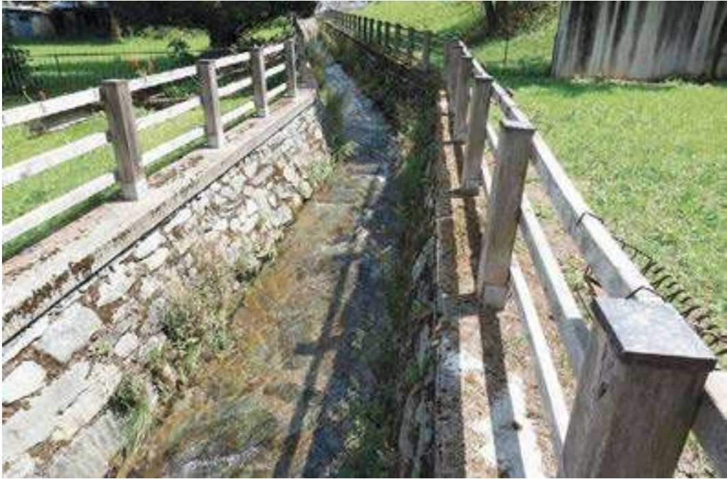
Figura 60. Canale che alimentava il vecchio mulino all'incrocio tra via Ezio Vanoni e via Bernina a Caspoggio.
