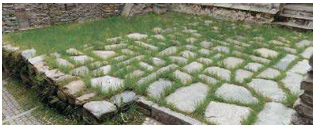
Figura 14. Piccola piazzetta a Primolo pavimentata con lastre di serpentinoscito. Nelle fessure le graminacee esprimono tutto il vigore primaverile.
