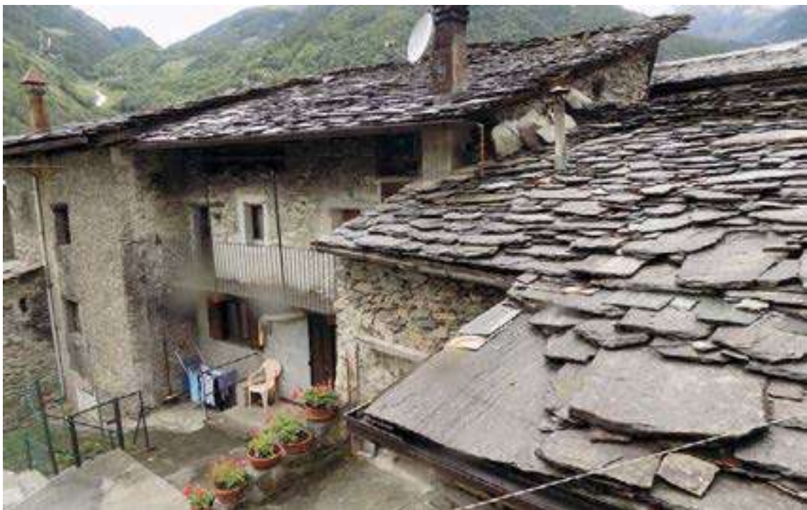
Figura 31. Particolare di una copertura in Ciatum de tèc di una casa a Cagni. Le differenze pezzature delle lastre e l'asimmetria della posa rende unica ogni copertura con queste pietre.
