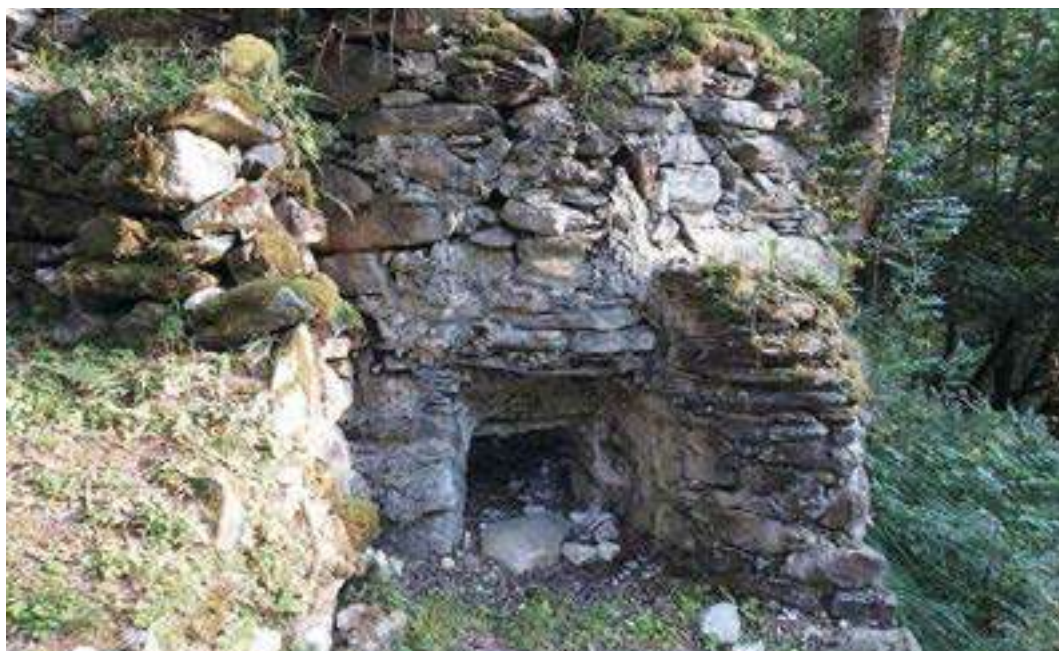
Figura 67. La bocca della seconda calchera per il caricamento della legna e l'alimentazione del fuoco.
