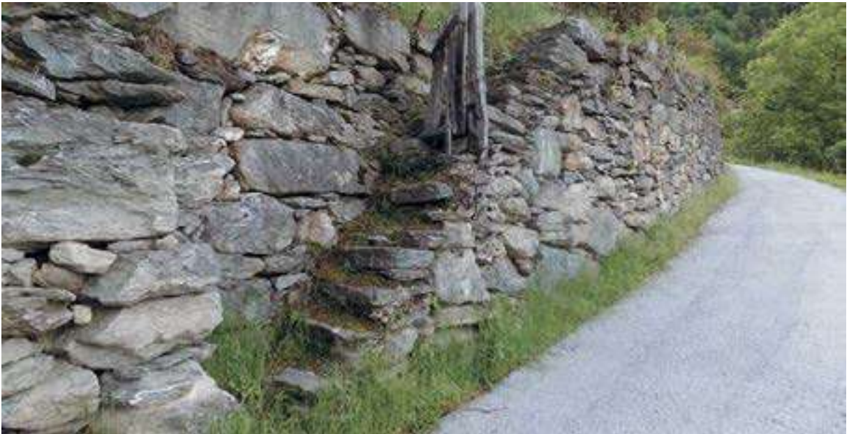
Figura 40. Le scale di accesso e di collegamento tra i poderi sono eseguite con massicci blocchi unitari e corrono parallele alle cortine murarie, come in questo accesso ad un terrazzamento sopra Arquino.
