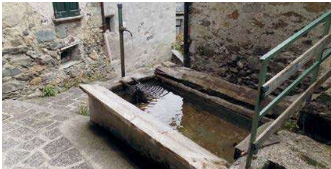
Figura 69. Il lavatoio a Primolo presenta due tavole di legno sui piani inclinati per facilitare il lavaggio della biancheria.
