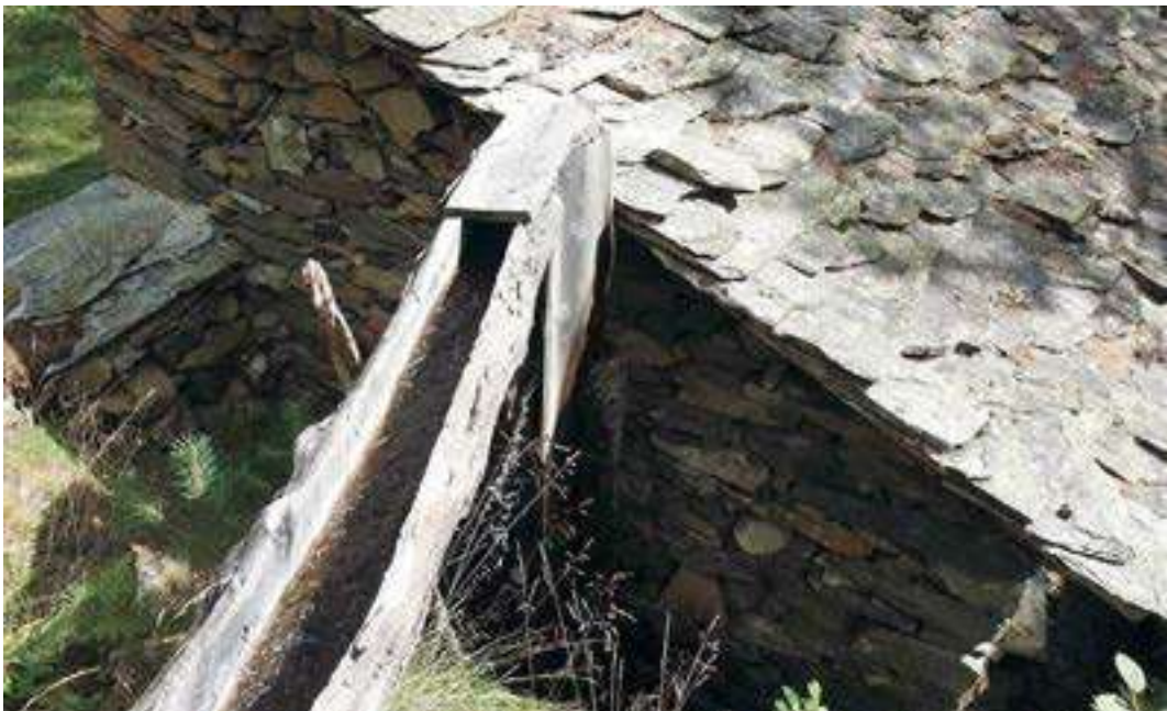
Figura 63. L'acqua del canale viene condotta sopra la ruota del mulino del tornio mediante una canaletta in legno.
