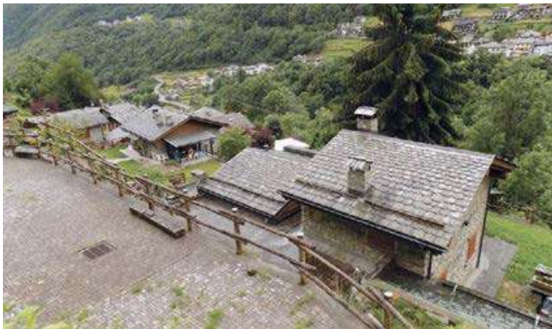
Figura 32. Tetti in Piode della nuova urbanizzazione lungo la strada per Cagni. L'uguaglianza delle pezzature delle piastre e la regolarità della posa, pur nella loro armonia, rendono tutte le coperture simili tra di loro.
