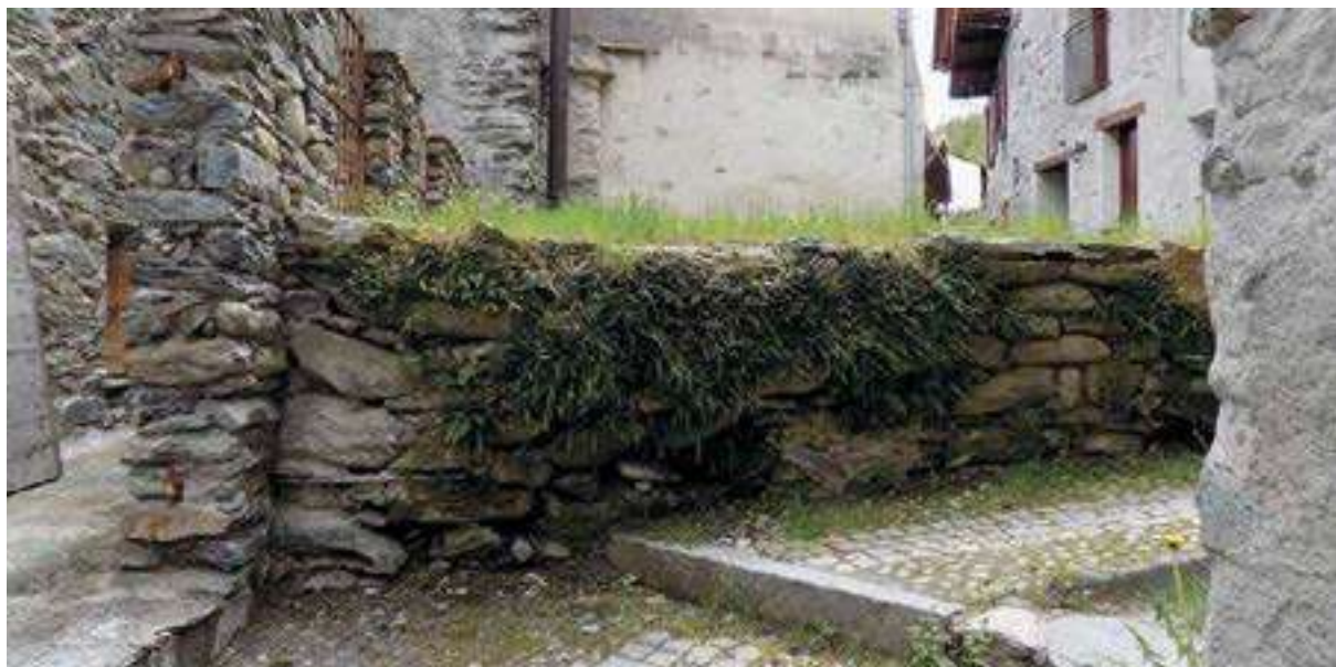
Figura 39. Muro in pietra a secco a sostegno di uno slargo a Primolo, ricoperto dalla piccola felce Asplenio tricomane .
