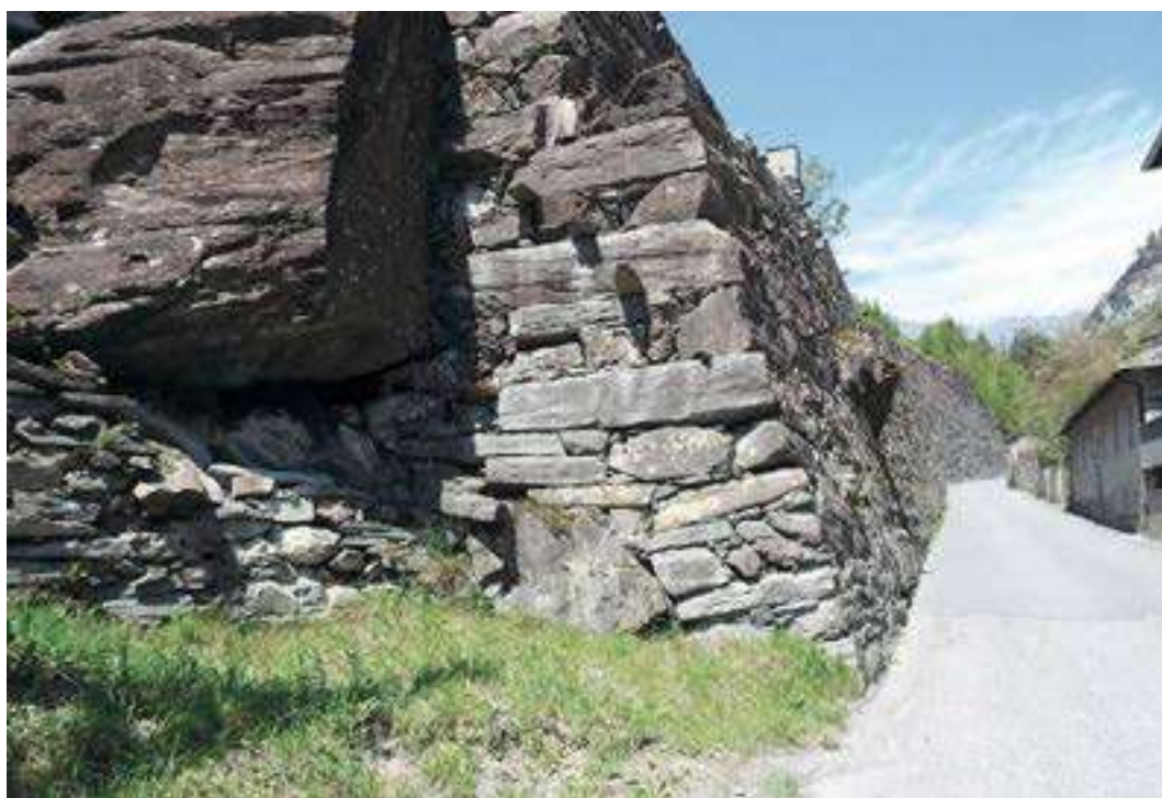
Figura 84. Imponente muro di sostegno del versante a difesa della strada verso Chiareggio in località Castellaccio costruito con scarti di cava.
