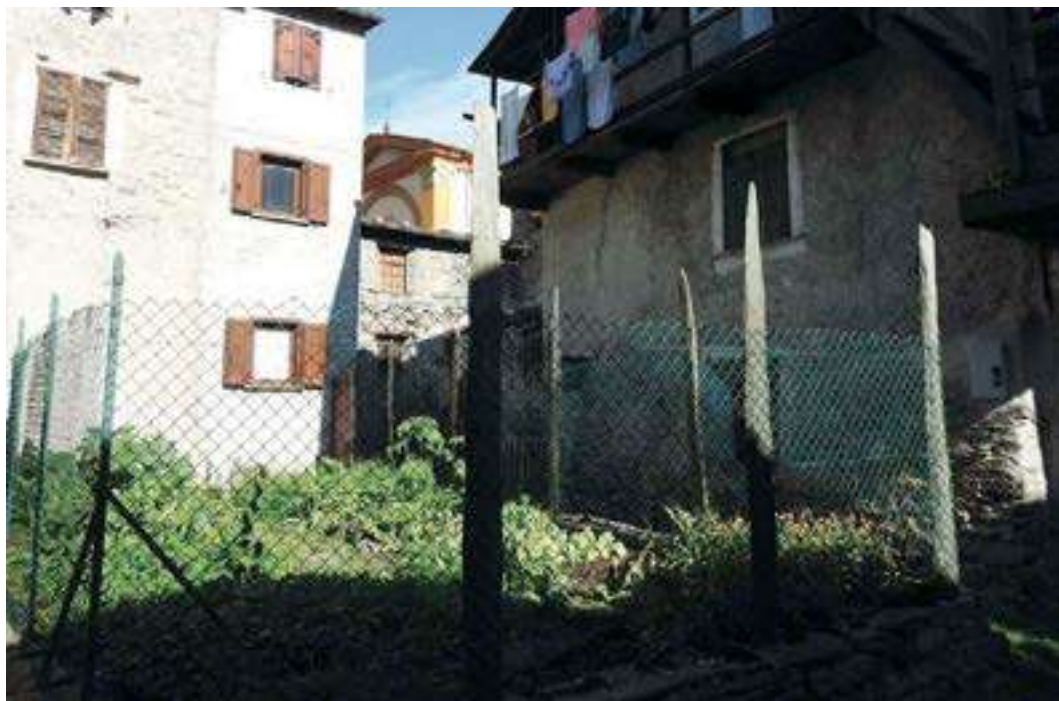
Figura 28. Recinzione di un orto a Vassalini con l'utilizzo di pali in serpentinoscisto chiamati localmente sfilzum .
