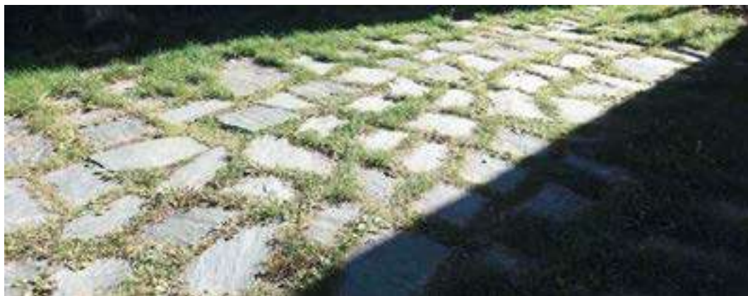
Figura 12. Slargo con lastre di serpentinoscito di fronte ad una abitazione a Marveggia.
