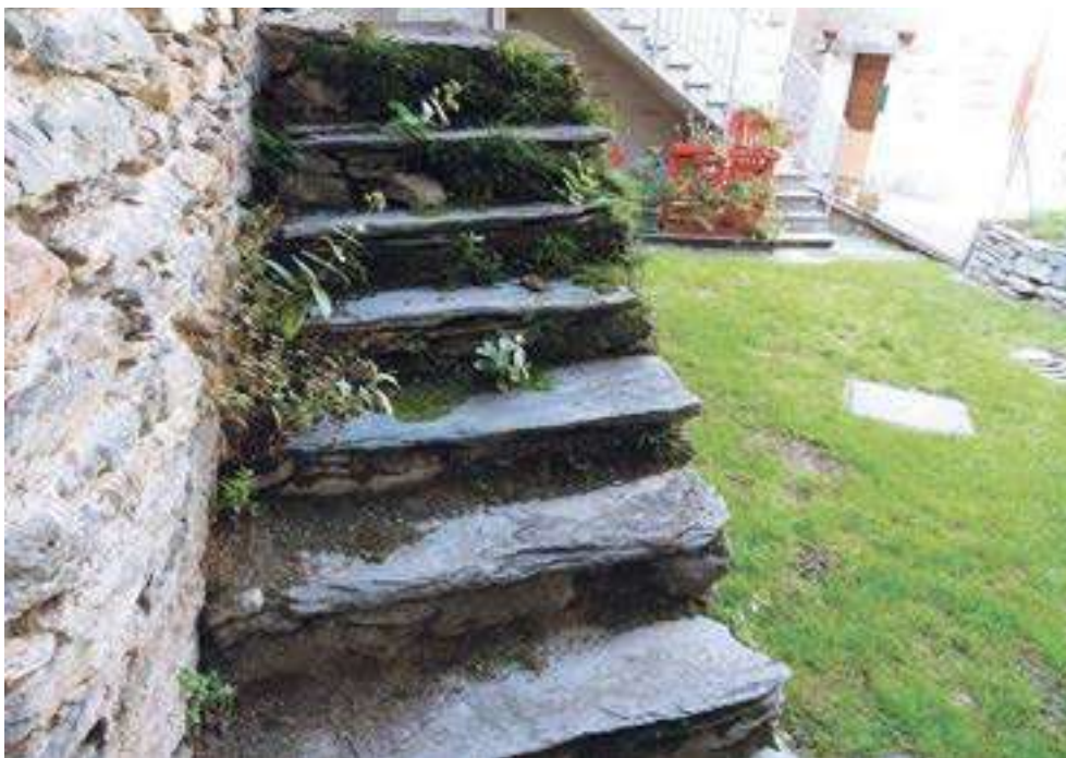
Figura 52. Scala in pietra a Vassalini. La Vegetazione, composta da Borracina maggiore, Asplenio tricomane e Geranio di San Roberto colonizzano preferibilmente il limite tra la pedata e l'alzata dei gradini e i bordi con la parete della casa, dove minore è il calpestio.
