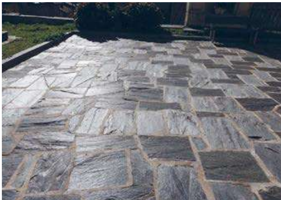
Figura 9. Sagrato della chiesa di Torre Santa Maria: pavimentazione contemporanea realizzata con lastre di serpentinoscisto. La scistosità planare che guida lo spacco manuale presenta anche una leggera anisotropia lineare secondaria, che, in funzione di come è orientata rispetto all'angolo di incidenza della luce, fa percepire il colore in maniera diversa. In realtà, tutte le lastre della pavimentazione hanno lo stesso colore.
