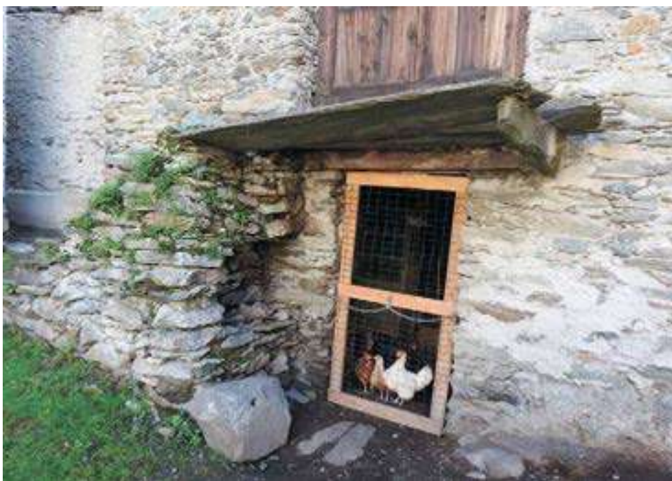
Figura 13. Vassalini, pianerottolo monolitico in serpentinocisto. Da notare la dimensione della lastra, lo spessore, sottilissimo e la distanza tra i due montanti di supporto, possibile solo grazie alla straordinaria elasticità (resistenza alla flessione) del serpentinocisto.
