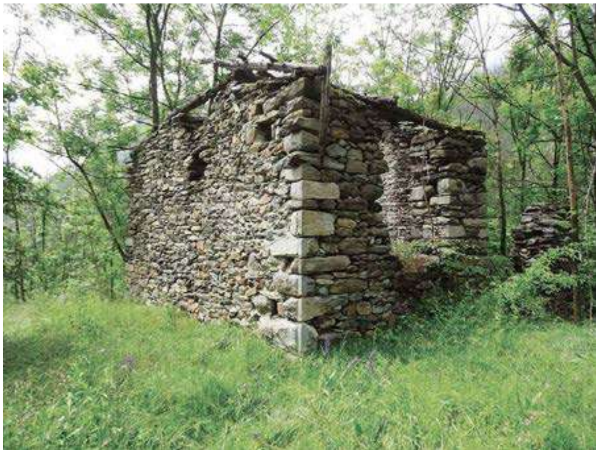
Figura 6. Dettaglio dell'angolo della torre realizzato in conci a bugnato rustico.
