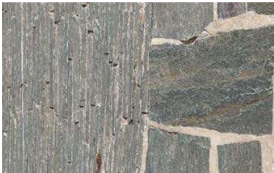
Figura 10. Sagrato della chiesa di Torre Santa Maria: pavimentazione contemporanea realizzata con lastre di serpentinoscisto. Particolare del raccordo tra la pavimentazione del sagrato, in piano, e la strada di accesso al percorso pedonale, in discesa. Data la forte acclività del percorso, la pietra è stata posata a coltello (come se fosse in smolleri di porfido), mettendo in evidenza la sezione scistosa della pietra, che così offre una maggiore resistenza allo scivolamento. Sono ben visibili gli allineamenti planari dei minerali lamellari.
