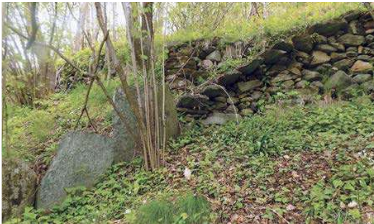
Figura 42. Pietre poste ortogonalmente ai muri, a sbalzo, consentono di superare il dislivello tra terrazzamenti sopra Vassilini.
