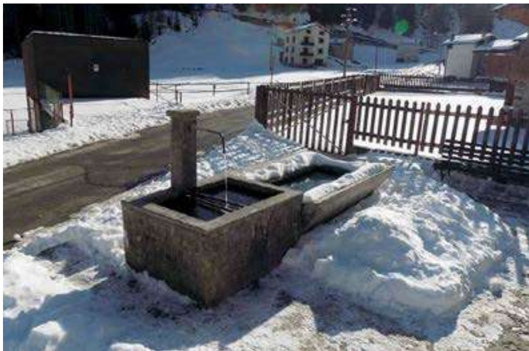
Figura 73. Una fontana di recente costruzione e l'attiguo lavatoio in struttura di cemento in località Francia.
