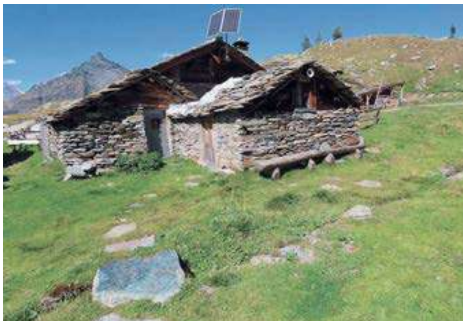
Figura 3. Malghe da alpeggio, in cui si legge la tessitura muraria realizzata con elementi a spacco naturale accuratamente selezionati e organizzati in corsi. Il manto di copertura è realizzato in piòde relativamente spesse. Si noti la grande pietra utilizzata come attraversamento del piccolo corso d'acqua. È una lastra spessa di serpentinite, immediatamente riconoscibile dal caratteristico colore verde-blu, reso ancora più evidente dalla levigatura naturale per l'usura da calpestio nel punto di passaggio "obbligato" dei pedoni.
