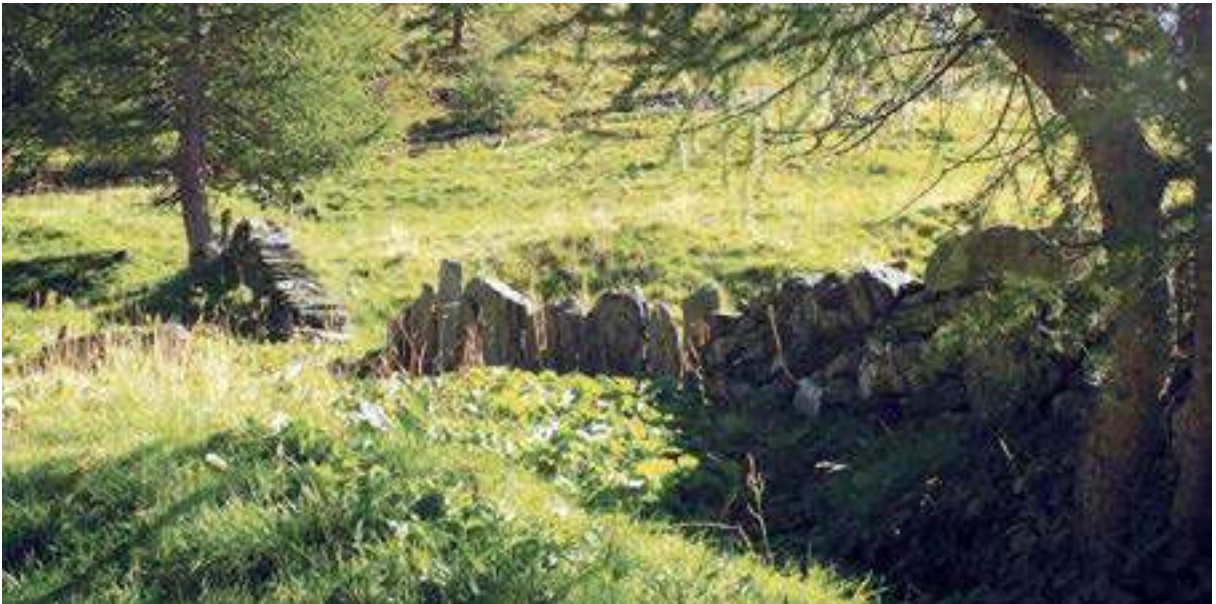
Figura 24. Delimitazione di proprietà con lastre in verticale all'Alpe dell'Oro.
