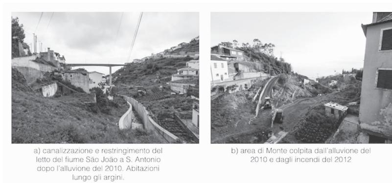
Fig. 5 – Percorso del fiume a S. Antonio dopo gli interventi post-alluvione e opere di ricostruzione a Monte.
