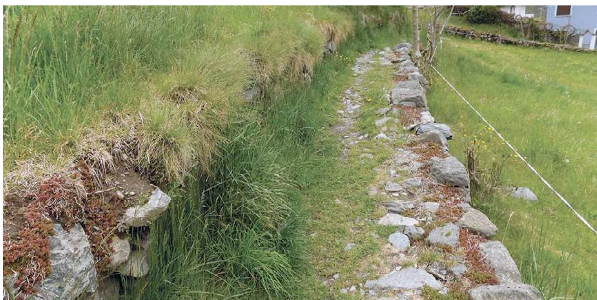
Figura 16. Mulattiera che da Vassalini porta a Lanzada, utilizzata tutt'oggi come percorso pedonale.
