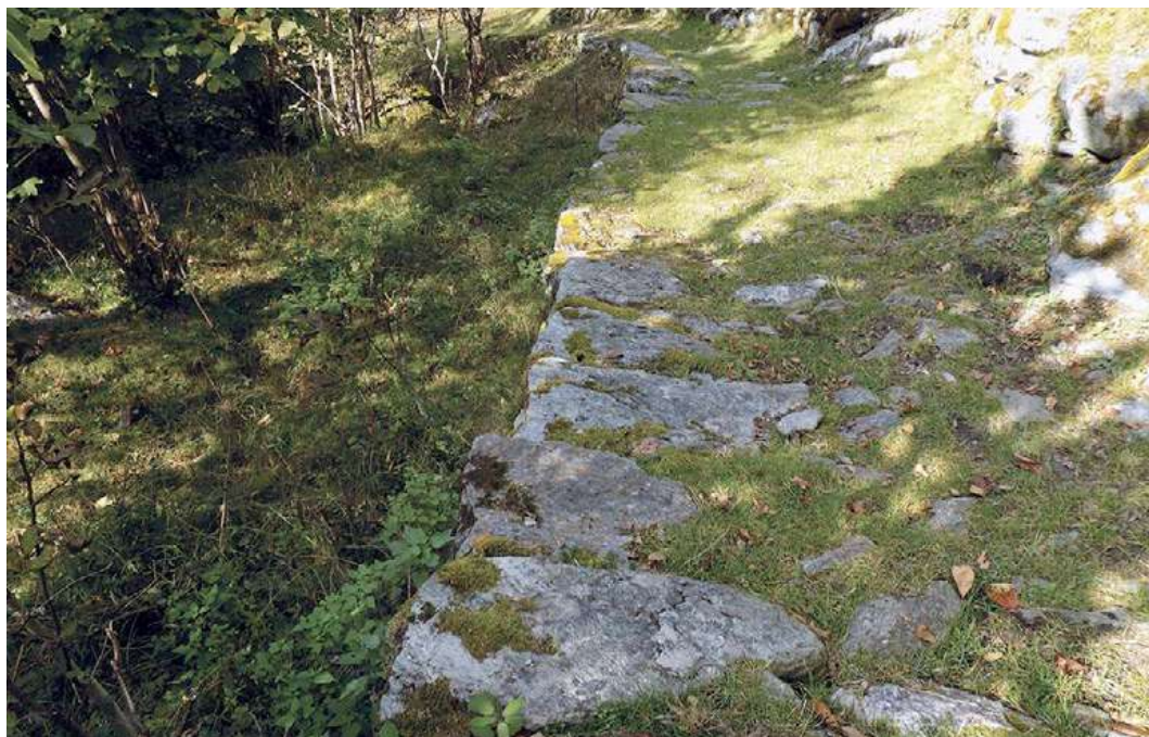
Figura 11. Mulattiera nei pressi di Marveggia. La tecnica costruttiva delle mulattiere prevedeva la posa di grosse pietre al bordo del tracciato per dare stabilità al sedime.
