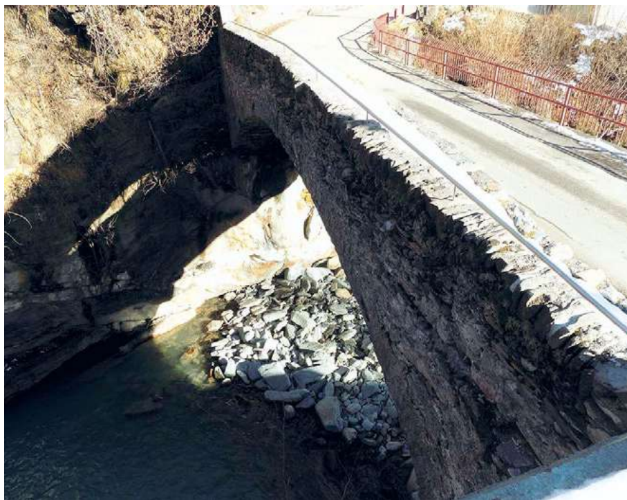
Figura 48. Il “Ponte del Curlo” connetteva Chiesa in Valmalenco alla contrada Curlo superando il torrente Mallero.
