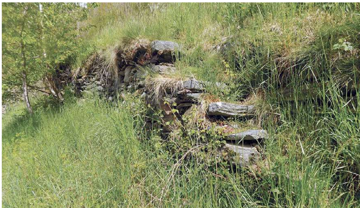
Figura 43. Scaletta di collegamento tra terrazzamenti sopra Vassilini fortemente inerbita.
