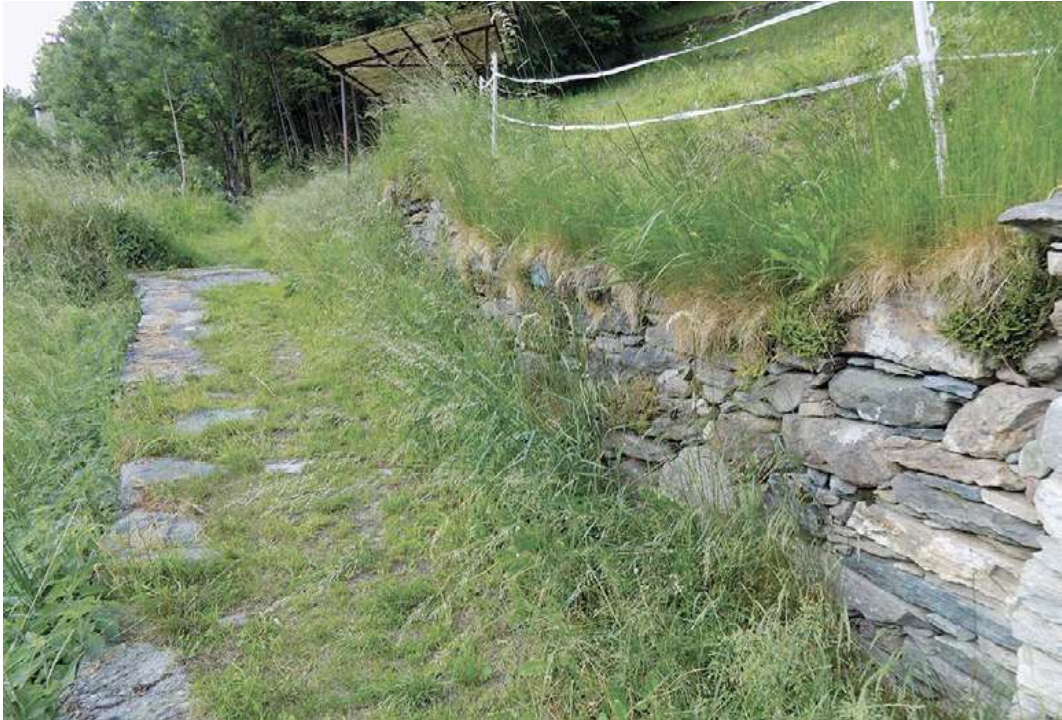
Figura 13. Un muretto a monte protegge la mulattiera a Cristini. Del selciato sono rimaste le grosse pietre sul lato esterno della mulattiera.
