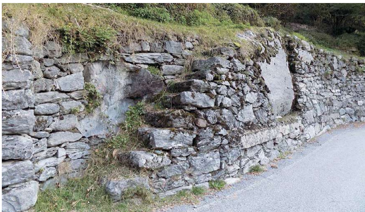
Figura 41. Scala di accesso ad un terrazzamento a Spriana.
