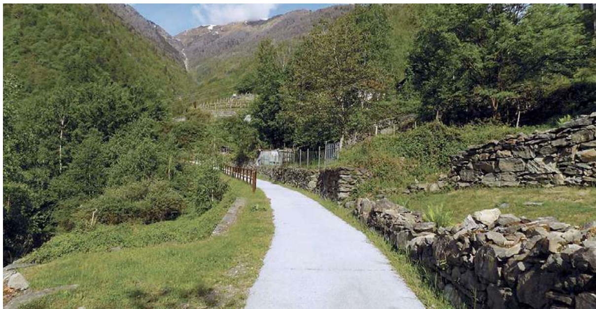
Figura 4. La strada “Cavallera” dopo il ponte di Arquino sale a Cagnoletti compiendo numerosi tornanti. Attualmente è asfaltata con funzione di percorso ciclopedonale.
