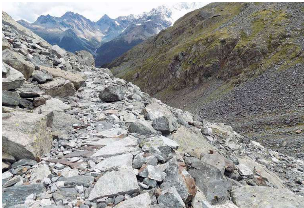
Figura 23. L'attraversamento di ghiaioni necessita di una perizia costruttiva del sedime stradale e di una manutenzione costante.
