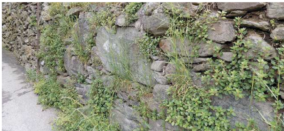
Figura 6. Il muretto è colonizzato da piante tipiche delle rupi e dei muri caldi, come il Ciomolino comune e la Vetriola minore.
