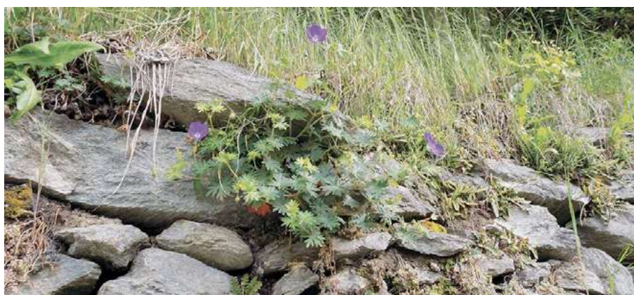
Figura 7. Il Geranio sanguigno, pianta dei prati aridi, trova spazio tra le pietre del muro di protezione della strada, favorito dall'esposizione a sud e dalla quota relativamente bassa.
