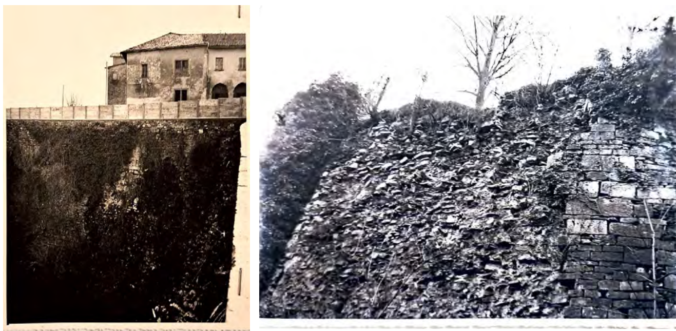
3: Sergio Tenni, Vista delle Mura sotto S. Agostino (a) e vista dell'orecchione del baluardo di S. Alessandro (b) 11 .
