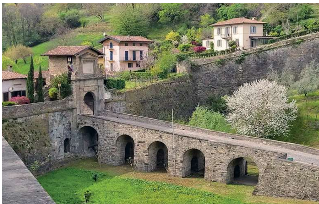
Fig. 1. La nuova Porta di San Lorenzo sull'antica preesistenza: vista del varco, della cortina e dei precedenti accessi (S.A.B.E. 2025).
