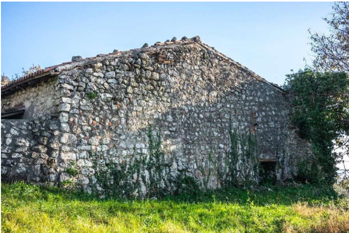
Figura 100, Figura 101 La struttura della chiesa di san Michele ripresa dal lato nord (in alto) e dal lato ovest (in basso). Fotografie dell'autore.
