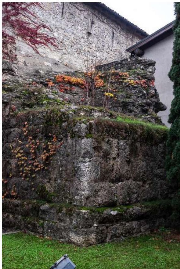
Figura 21, Figura 22, Figura 23, Figura 24 Le fotografie si riferiscono alle vie interne al perimetro del castello di Coccaglio, a un particolare con giustapposizioni di murature differenti e, da ultimo, la parte basale di una torre. Fotografie dell'autore.
