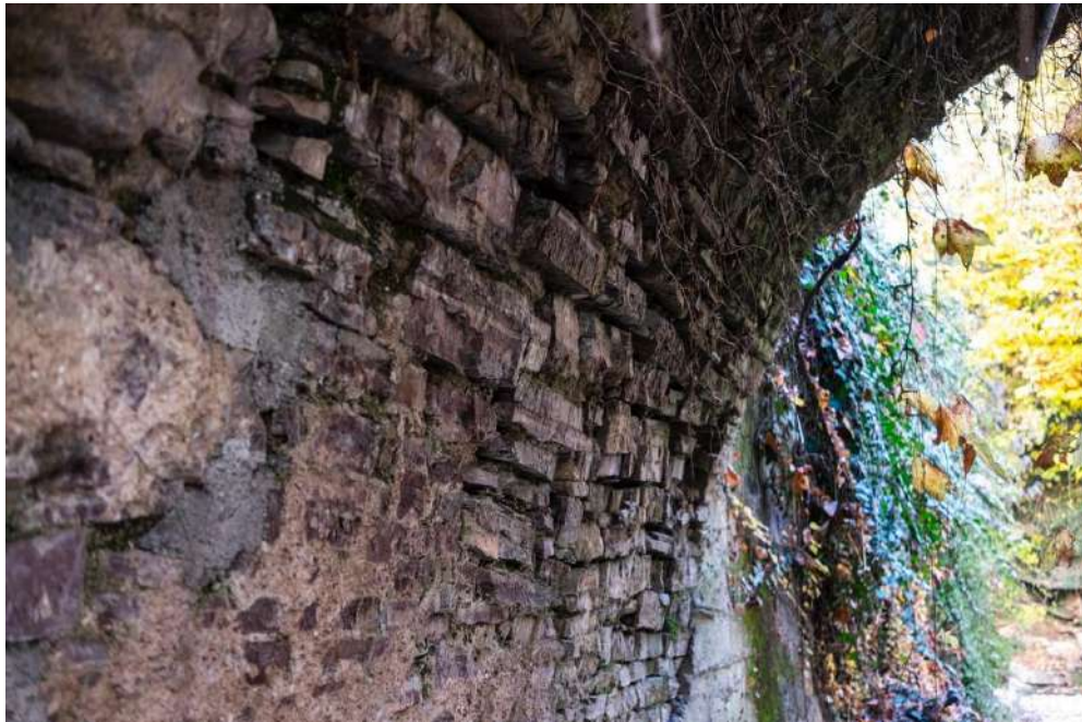
Figura 55 Un particolare della muratura del ponte posto sull'ansa del torrente. Fotografia dell'autore.
