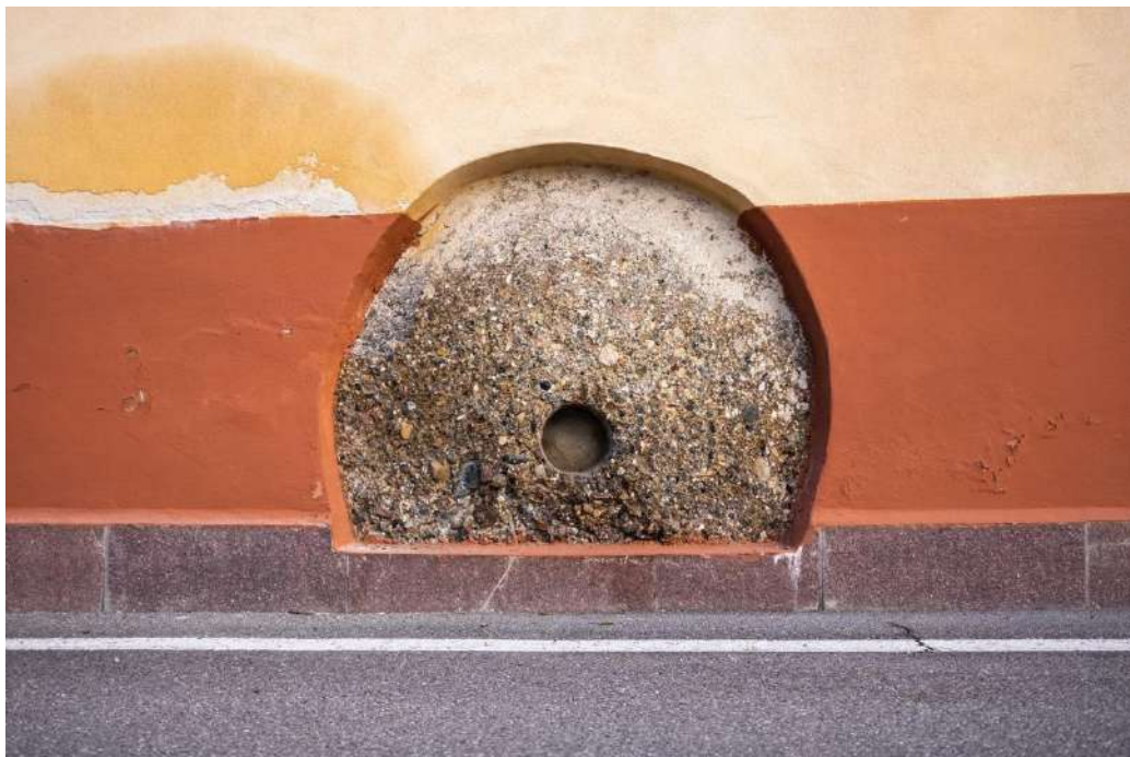
Figura 51 Una ruota molitoria reimpiegata all'interno della muratura di un edificio a Foina. Fotografia dell'autore.
