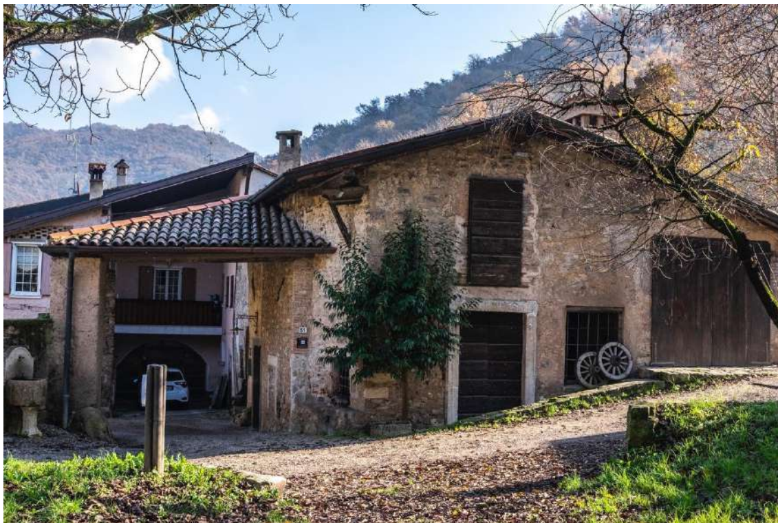
Figura 68 L'ingresso degli edifici del maglio di Ome. Fotografia dell'autore.
