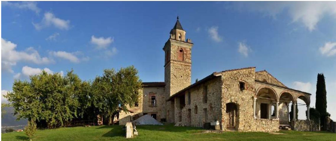
Figura 41 La facciata ovest della Santissima prima dei recenti restauri. Fotografia di Tommaso Tabacchini.
