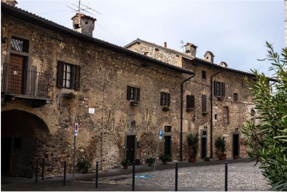
Figura 30 Edifici interni al castello, attualmente destinati a diversi utilizzi. La fotografia è scattata accanto alla pieve, dall'interno dell'antico castello. Fotografia dell'autore.
