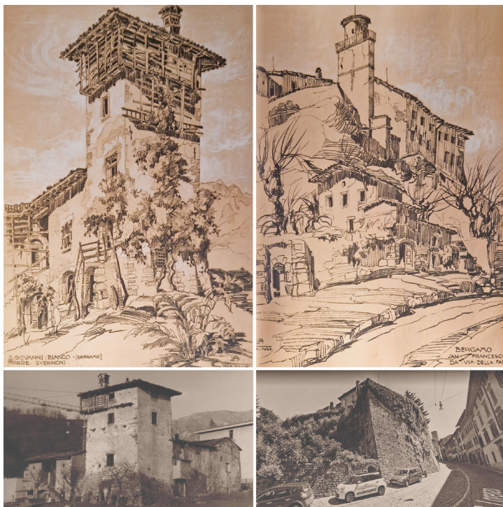
Fig. 2 - La Torre Guerinoni a San Giovanni Bianco e il Convento di San Francesco a Bergamo: confronti tra il passato e il presente (rielaborazione degli autori).
