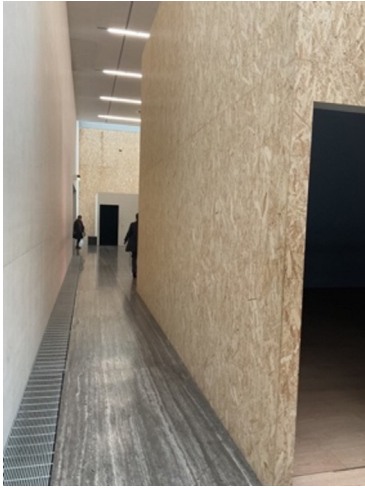
Fig. 11. Pannelli in OSB delimitano gli spazi espositivi della Torre.
