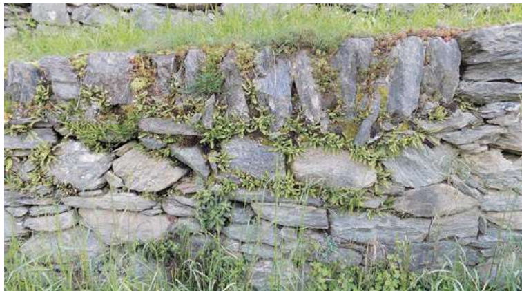
Figura 15. Muro di sostegno di un terrazzamento a vite a Cagnoletti. I massi alla sommità sono posati con perizia a coltello e ospitano tra gli interstizi numerose piante della piccola felce Cedracca comune.
