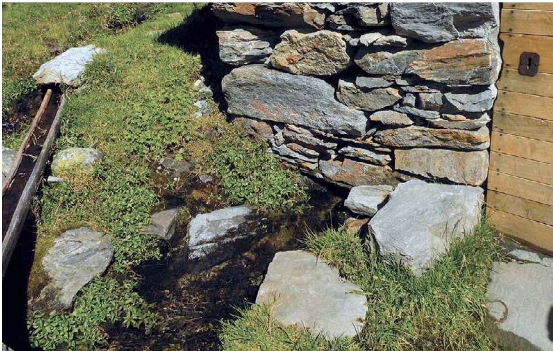
Figura 46. Una sorgente di acqua fredda alimenta il flusso idrico nei caselli dell'Alpe Prabello. L'acqua della sorgente è deviata a monte all'interno di ogni casello, per essere restituita a valle.
