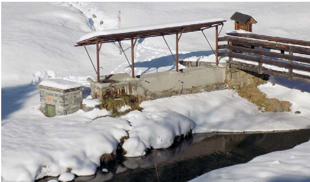
Figura 56. In località Caral un abbeveratoio, a valle di una fontana-lavatoio di recente costruzione, a servizio delle mandrie in transumanza verso gli alpeggi.
