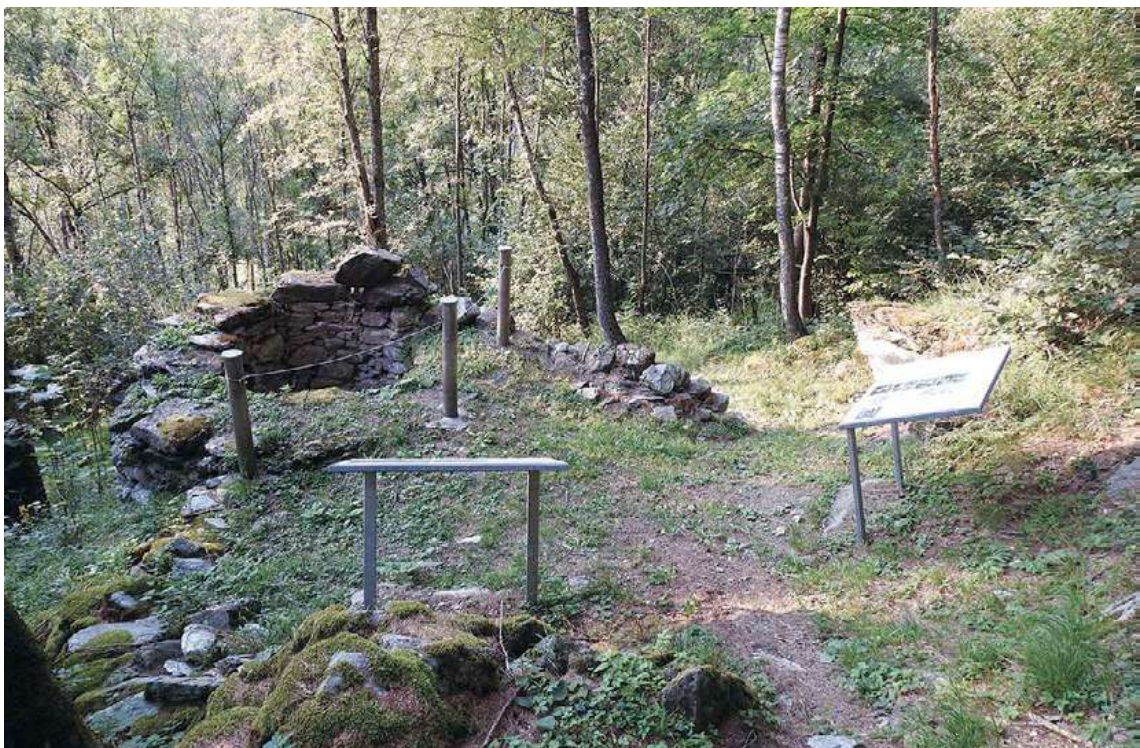
Figura 69. La seconda calchera di Tornadri, più a monte della prima.
