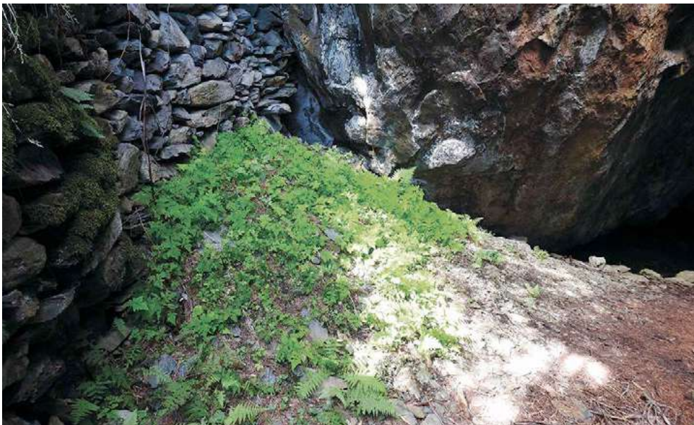
Figura 81. L'umidità del luogo ha favorito la crescita di numerose felci sulla discarica della miniera.
