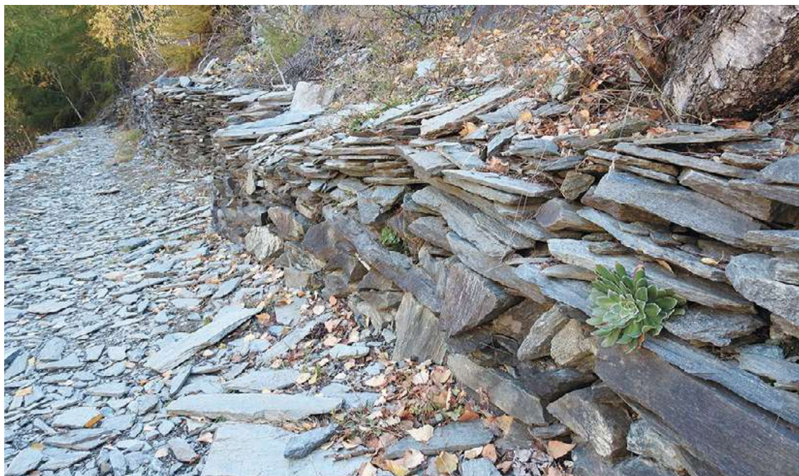
Figura 90. I muretti di protezione della viabilità interna pedonale al Giovello ospitano piante rare come la Sassifraga dei graniti.
