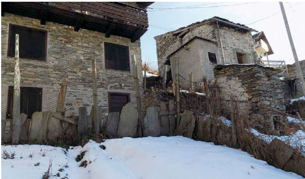
Figura 29. Recinzione di un orto a Pedrotti con pali di serpentinoscisto. Lungo il perimetro dell'orto sono state collocate in verticale lastre in pietra a protezione termica delle colture orticole.
