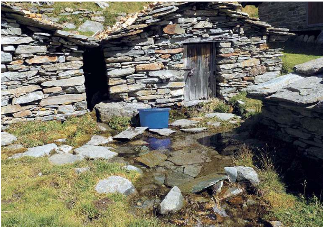
Figura 48. All'uscita del casello del latte l'acqua defluisce verso il ruscello a valle.
