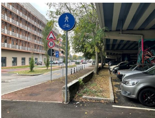
Casa Integra, sulla sinistra, si affaccia sul Viadotto
