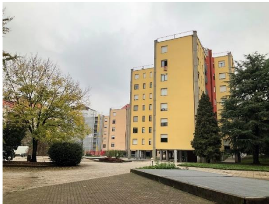
Complesso di case in via Borgo Palazzo
