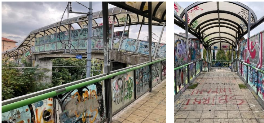
Il passaggio pedonale sovrastante il sedime ferroviario, sovrappasso Boccaleone
