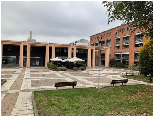
Vista su Largo Quarenghi
