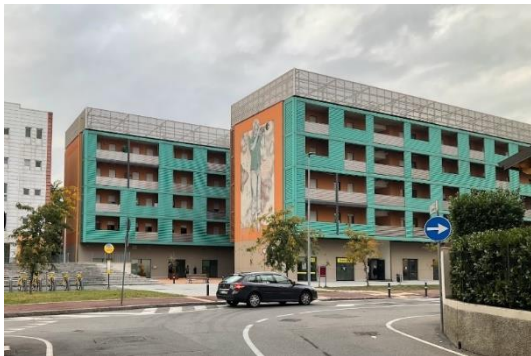
Edifici di Casa Integra, da via Boccaleone
