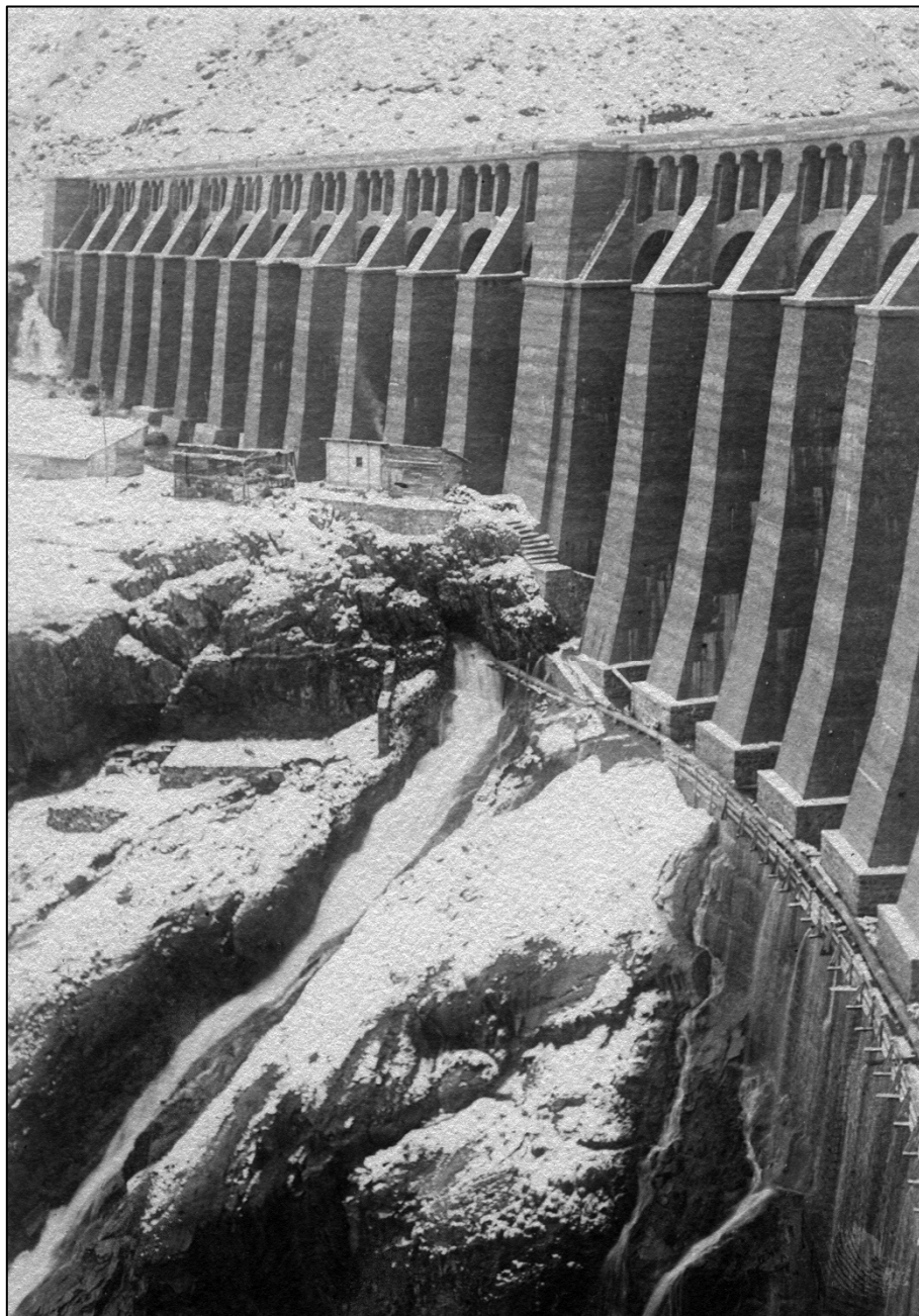
Fig. 34 – La diga ad archi multipli (per gentile concessione di Archivio Ing. Conti)
