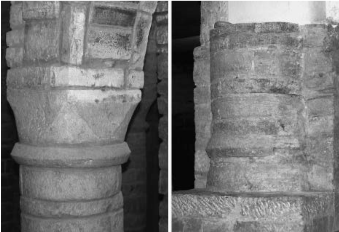
FIG. 13. Particolari dei collarini nei pilastri della cripta di S. Maria Assunta a Guardialfiera (a sinistra) e della cattedrale di Termoli (a destra) (foto dell'autore)
