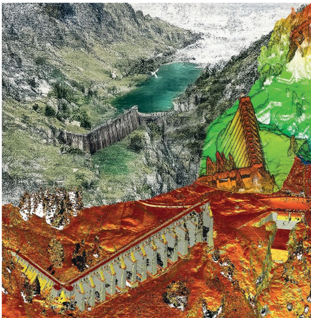
Fig. 4. Diga del Gleno: modello geometrico e valori morfometrici, espressi in termini di Dip e Dip Direction, per l'analisi dell'orientamento delle superfici e delle relative variazioni.
