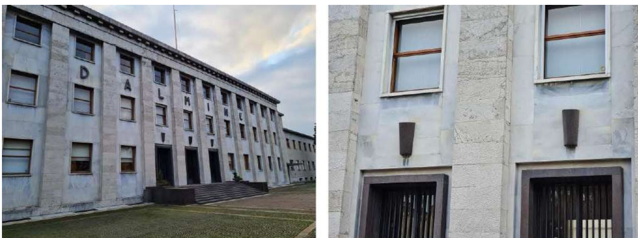
5: Il palazzo della Direzione oggi, dopo la ricostruzione. A destra il dettaglio delle lastre integrate dopo l'eliminazione dei balconi. Sul fianco delle paraste si notano le sedi di attacco delle balaustre (foto G. Mirabella Roberti).
