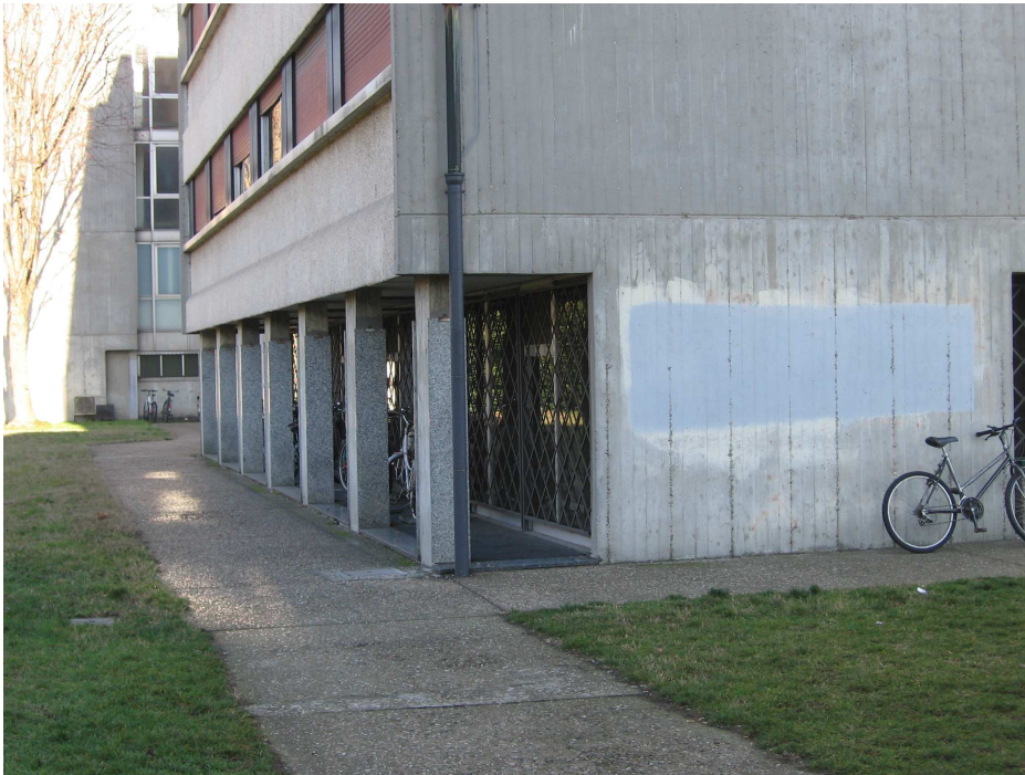
Figura 4. Particolare del porticato: in evidenza i pilastri portanti in cemento armato.
