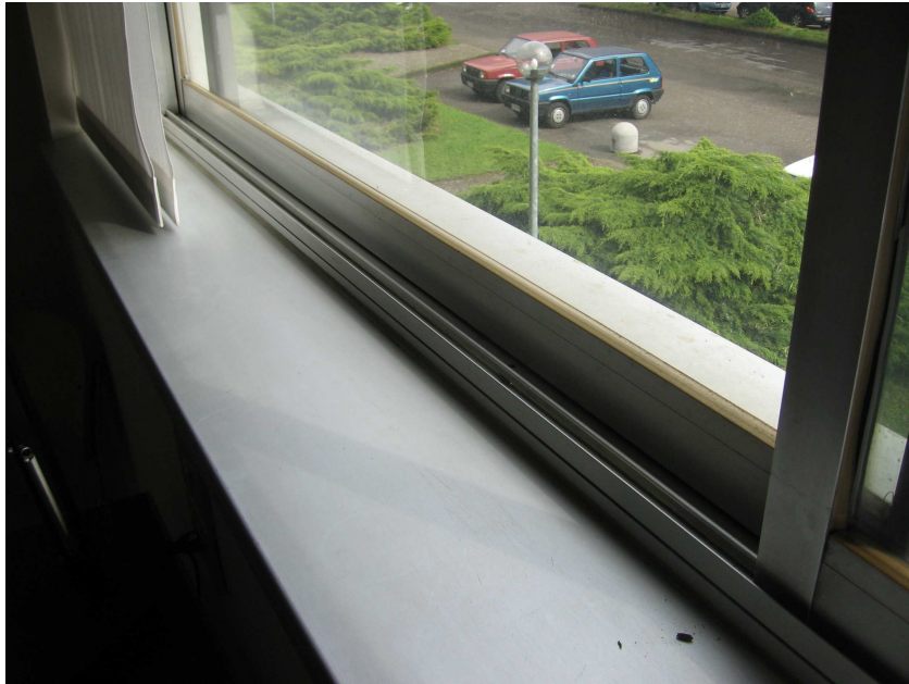
Figura 15. Particolare del telaio in alluminio e del sistema di apertura scorrevole
