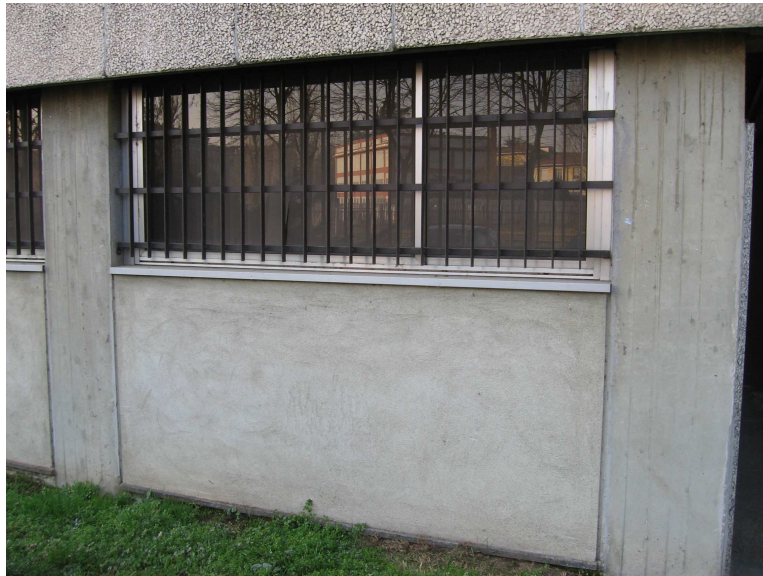
Figura 7. Particolare della chiusura verticale del piano terra.
