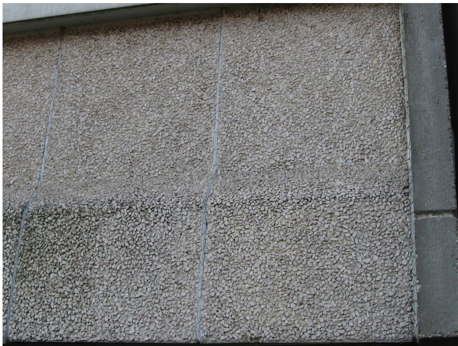
Figura 8. Particolare dei pannelli esterni
