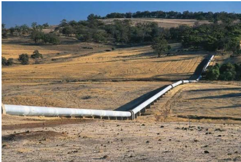
Fig. 1: condotta per il trasporto di acqua dolce
