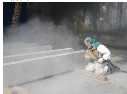
Figura 2 – Sabbatura delle travi
