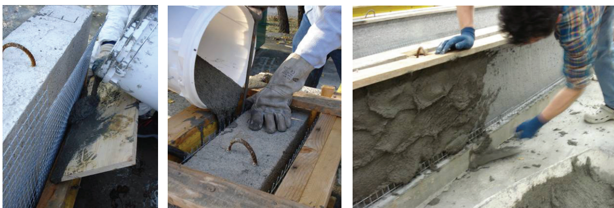
Figura 4 – Particolari relativi al getto del rinforzo
