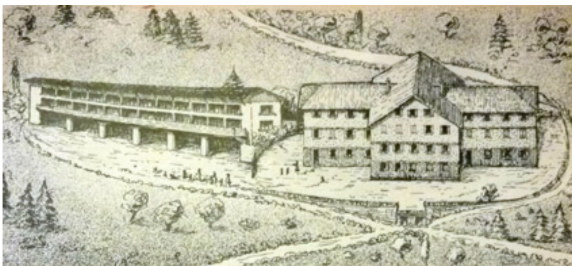
COLONIA DI SAINT-CERQUES-LES-VOIRONS (Alta Savoia) a 19 km. da Ginevra. Alt. 700 m. - 800 m. 2 di terreno. 154 letti - in attività dal 1930. Costruita dal 1930 al 1933 grazie al lavoro volontario di 425 operai - 3000 giornate di lavoro gratuito. - Nuova costruzione in stile al chalet già esistente; palestra coperta di m. 42 X 6, sormontata da padiglione-solarium.
