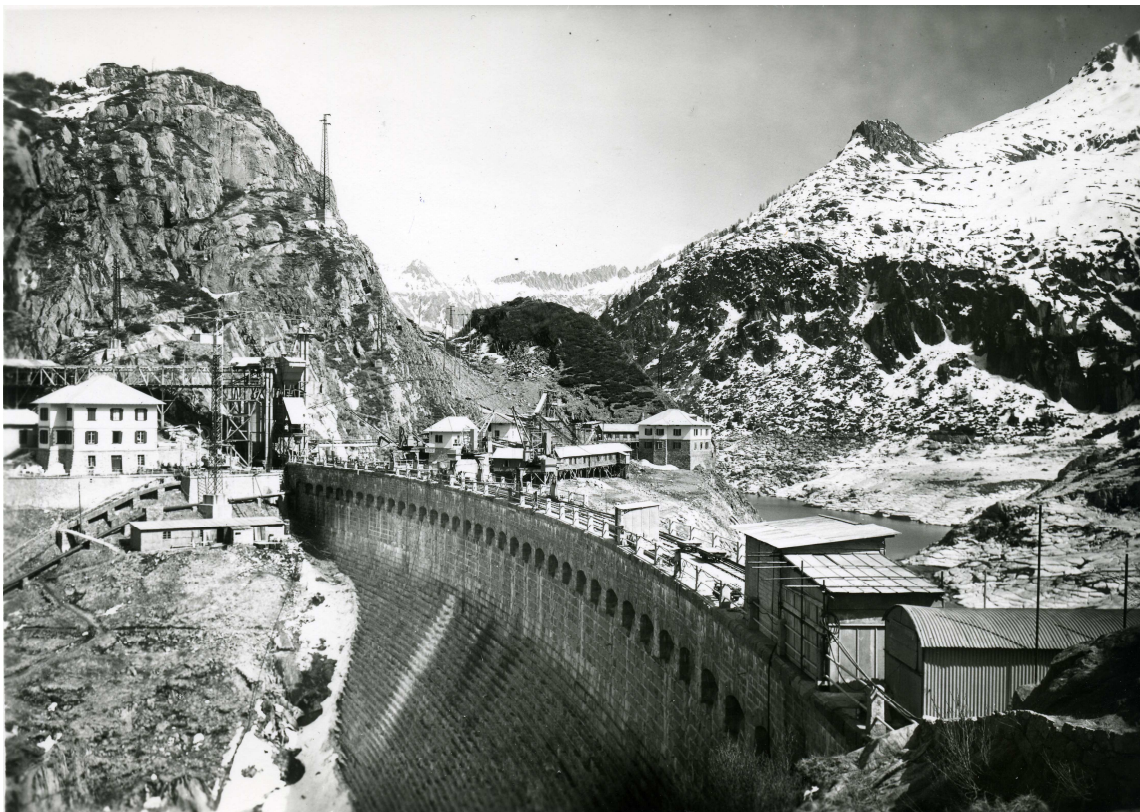
Società Generale Elettrica Adamello: fase di ultimazione della costruzione della diga del lago d'Arno, primi anni '20
