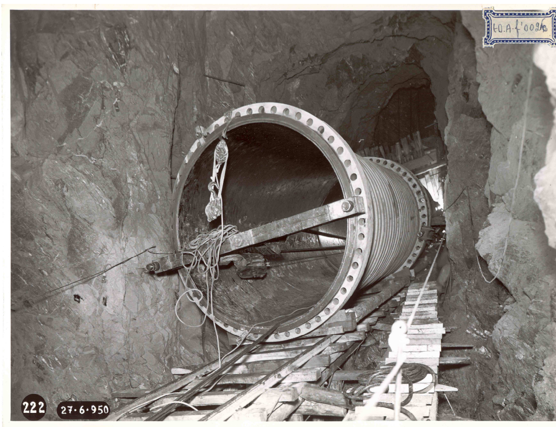
Condotta forzata costruita in galleria per l'impianto Sonico- Cedegolo
