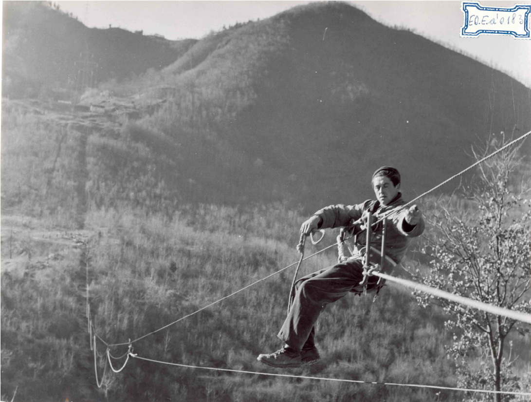
Operaio addetto al posizionamento delle linee elettriche
