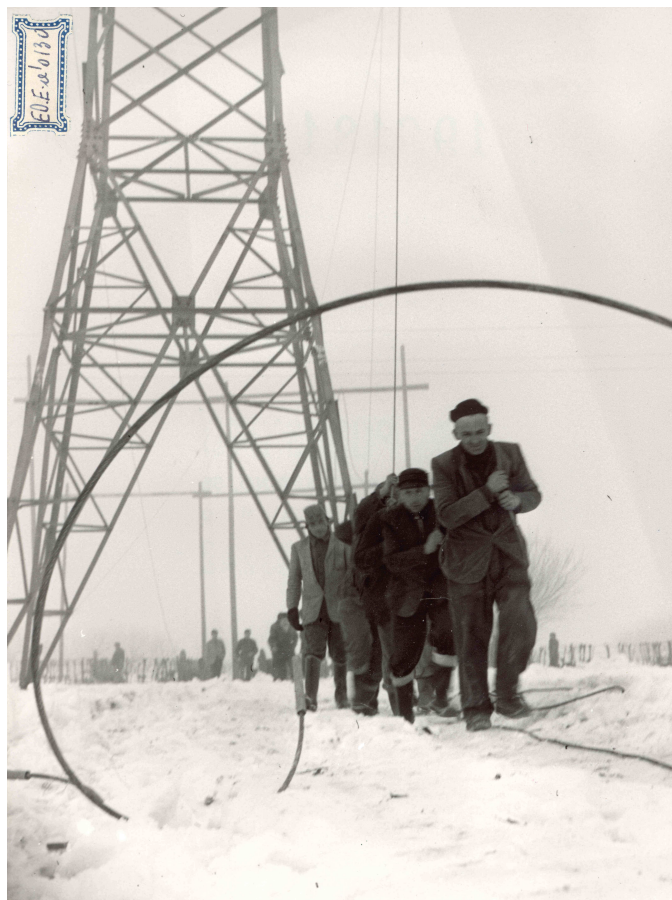
Lavoro di squadra per la tesatura dei cavi elettrici
