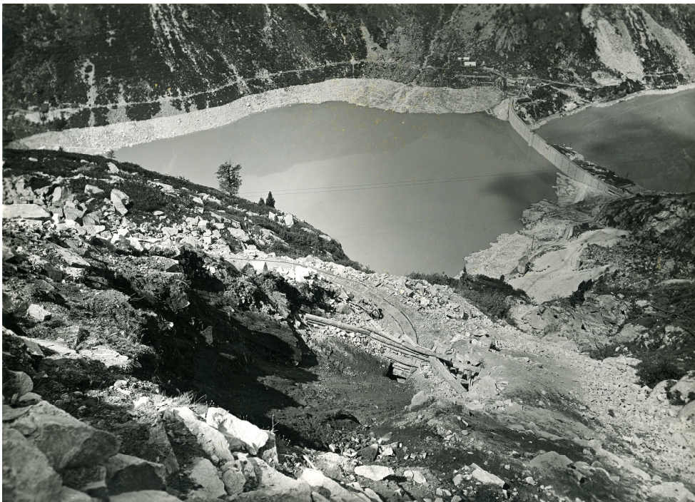
Vista dei serbatoi artificiali del lago Benedetto e del sottostante lago d'Avio
