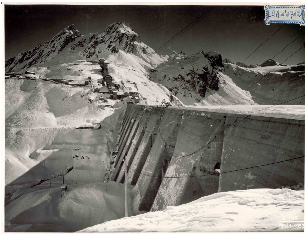
Società Edison: sbarramento del Pantano d'Avio, 1953
