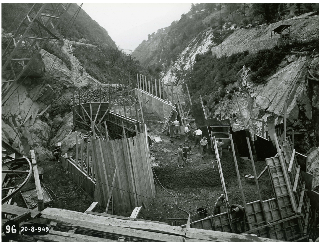
Società Edison: operai al lavoro presso la diga del Poggia, impianto Sonico- Cedegolo, 1949
