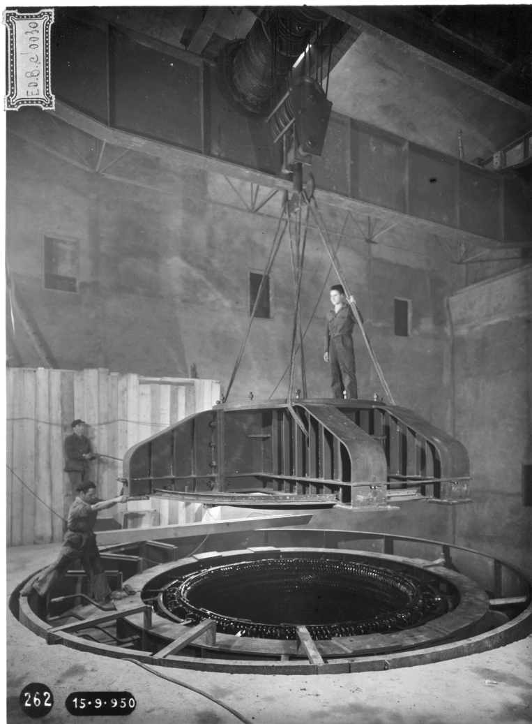
Installazione dei gruppi turbina alternatore all'interno della centrale di Cedegolo 2
