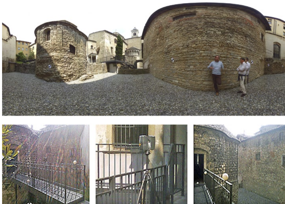
Fig. 7 – La chiesa di Santa Croce: la campagna di rilievo eseguita con il FARO Focus3D. Particolare dei target (mark checkerboard e mark registration spheres) impiegati per la rete di inquadramento.
