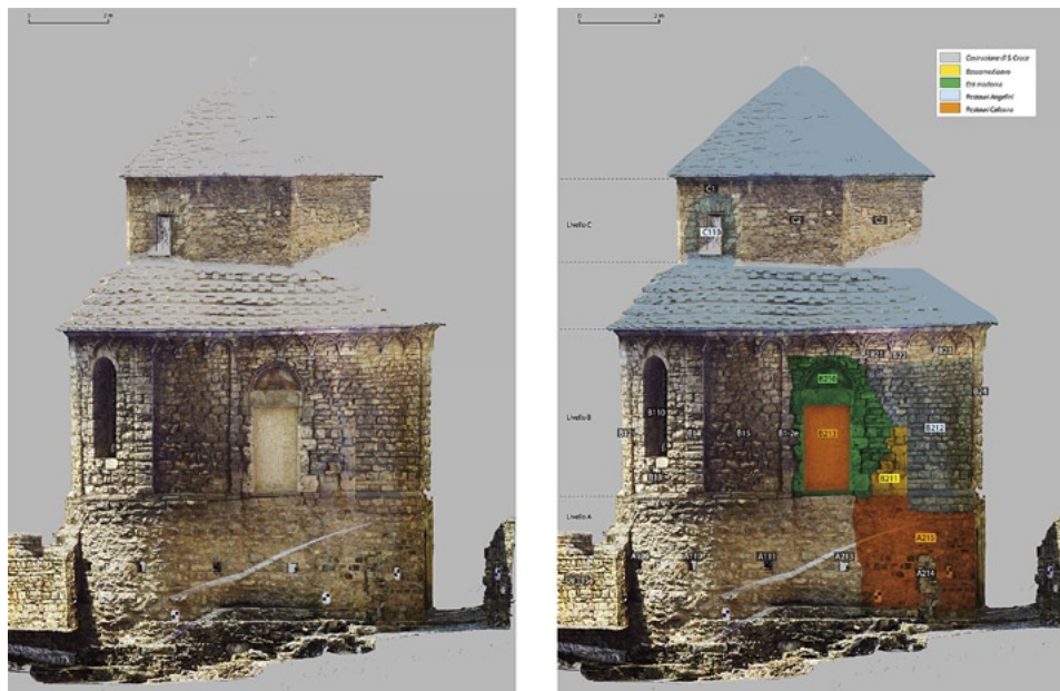
Fig. 4 – La chiesa di Santa Croce: proiezione ortografica dei prospetti e sovrapposizione dell’analisi stratigrafica con i riferimenti alle Us individuate.
