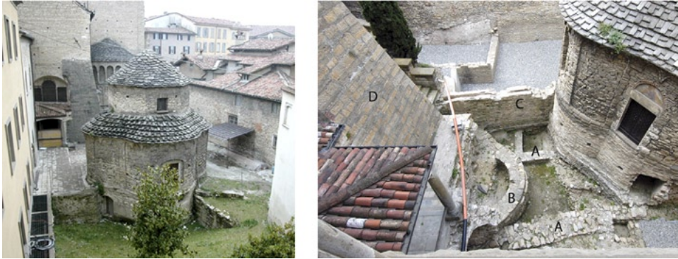
Fig. 3 – La chiesa di Santa Croce prima dello scavo e l’area attorno a fine scavo (2004): a) Edifici di età romana; b) Edificio trilobato (o quadrilobato?); c) Acquedotto a cavallo del quale è stata costruita la cappella di Santa Croce; d) Sperone rinascimentale a sostegno della cattedrale di Santa Maria Maggiore (foto Studio Arch. Calzana).
