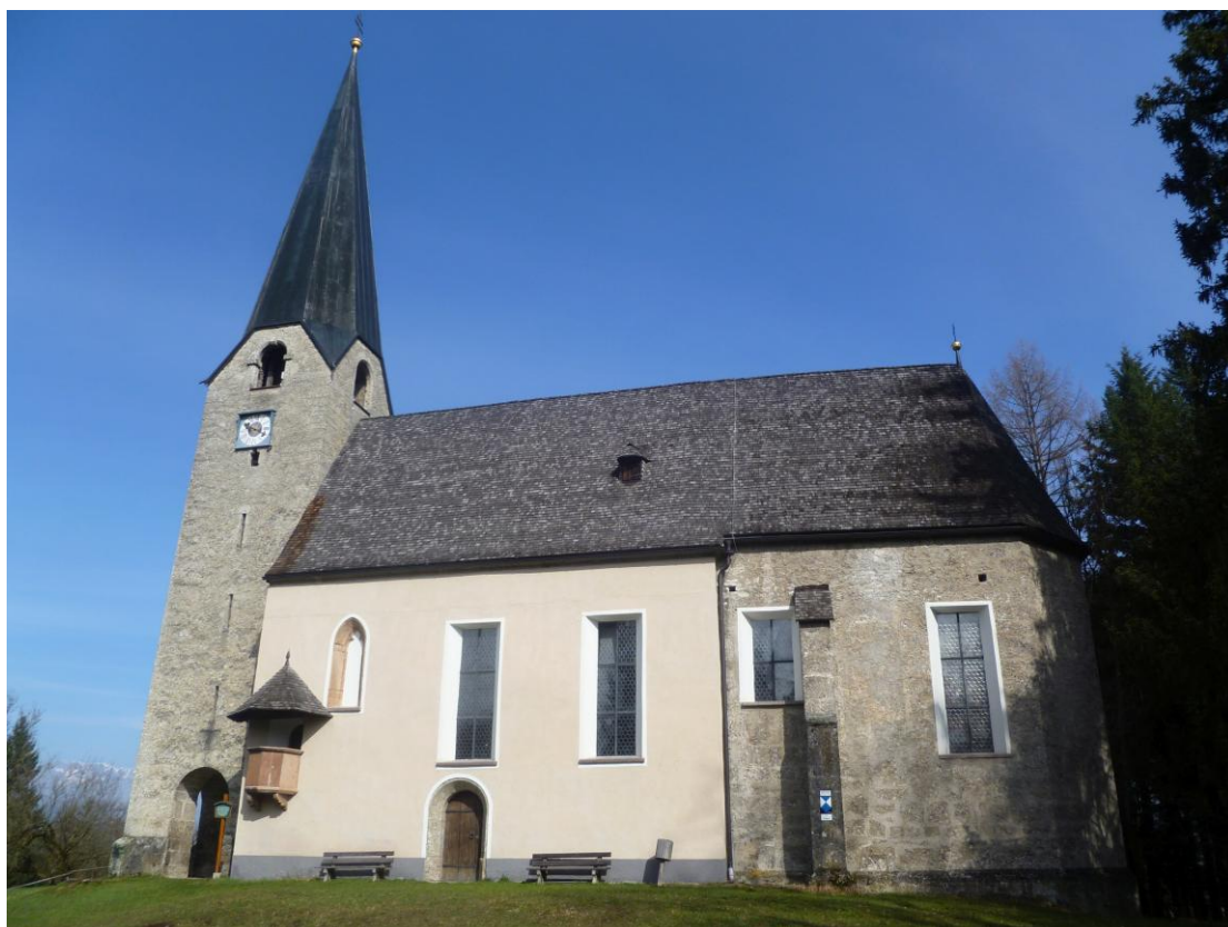
Figura 3: Facciata laterale della chiesa di San Giorgio (fotografia personale)
