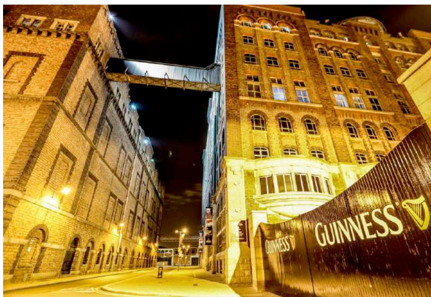
Figura 2. La Guinness Storehouse a Dublino, esterno.
