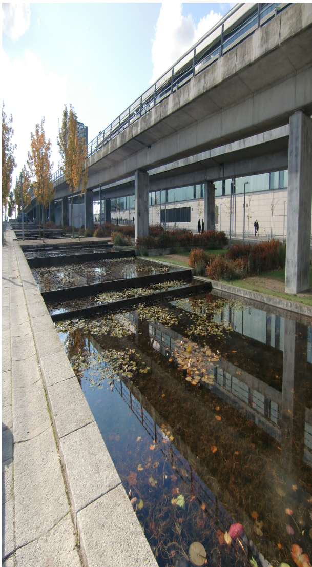
Figura 87 Canale di fronte alla scuola, (F.d.A.)
