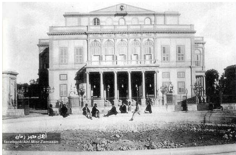
FIG. 13 – Teatro dell'Opera del Cairo a costruzione appena terminata (1869).
