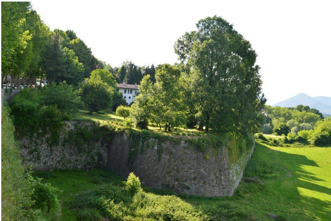
Fig. 6 - Mura di Bergamo (Lombardia, Italia). Baluardo della Fara. Tratto degli spalti di proprietà privata in cui non sono stati realizzati i parapetti: esempio della minore attenzione rivolta, durante il XIX secolo, al lato settentrionale della Fortezza rispetto a quello sud-occidentale (Campus 2017).
