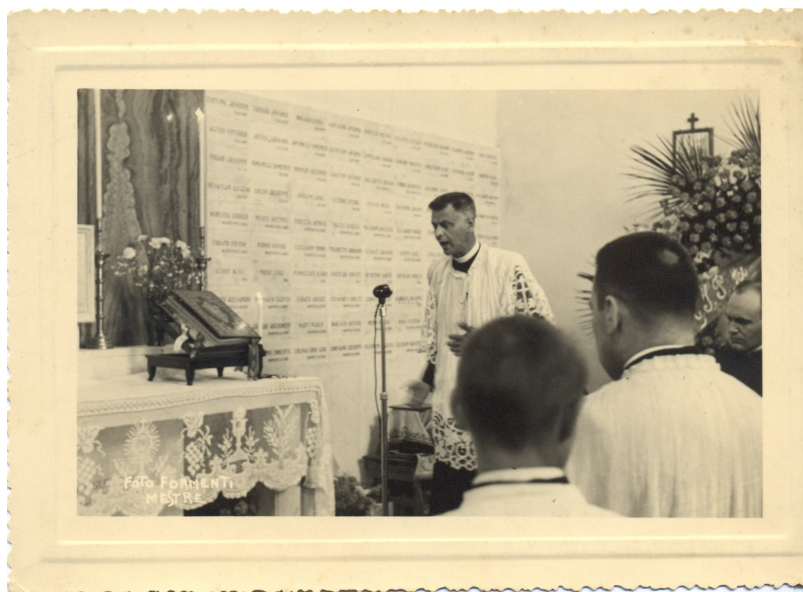
Figura 14. 1955: don Armando Berna inaugura la Cripta-Tempio per i caduti sul lavoro di Porto Marghera. Sullo sfondo, sono riconoscibili le piastrelle in marmo con i nomi degli operai deceduti. 71
