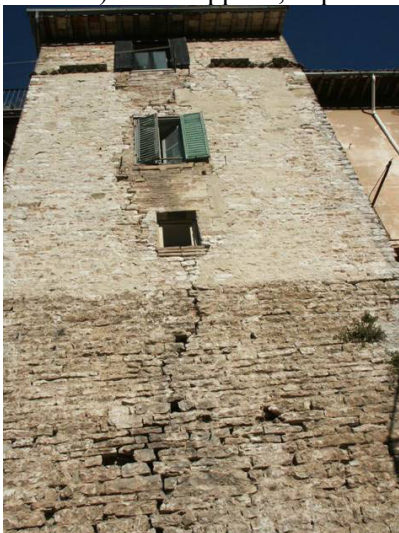
Livello 1 (sopra) Lesioni diffuse con enucleazione dei singoli elementi; assenza di comportamento a blocco rigido (sagrestia chiesa di Colle).
