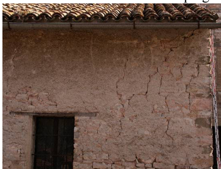
Livello 1 (sopra) Lesioni diffuse con enucleazione dei singoli elementi; assenza di comportamento a blocco rigido (sagrestia chiesa di Colle).
