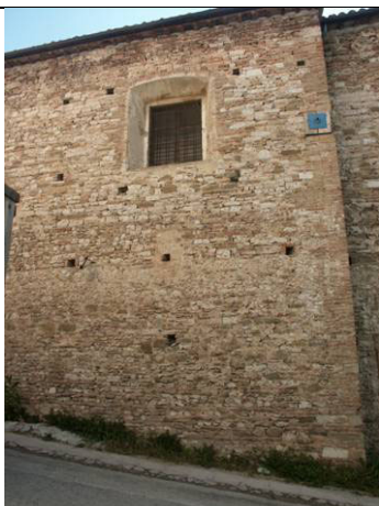
Livello 5: unica fase costruttiva prevalente, buono stato di conservazione, assenza di dissesti
