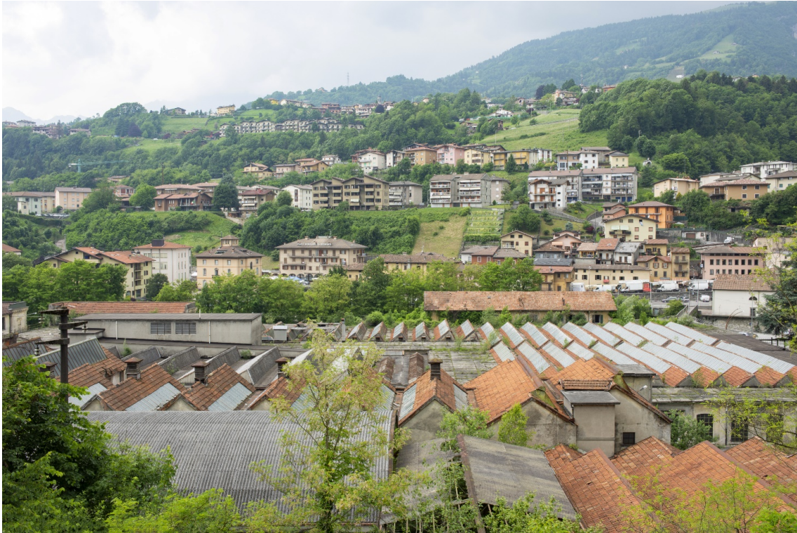
Figura 4 | I vecchi reparti di filatura e tessitura risalenti alla fine del XIX secolo, con le tipiche coperture a shed. Sullo sfondo, gli abitati di Ponte Nossola e Premollo sviluppatisi in tempi recenti sui pendii precedentemente coltivati. Fonte: fotografia di Marcello Modica© (2018)
