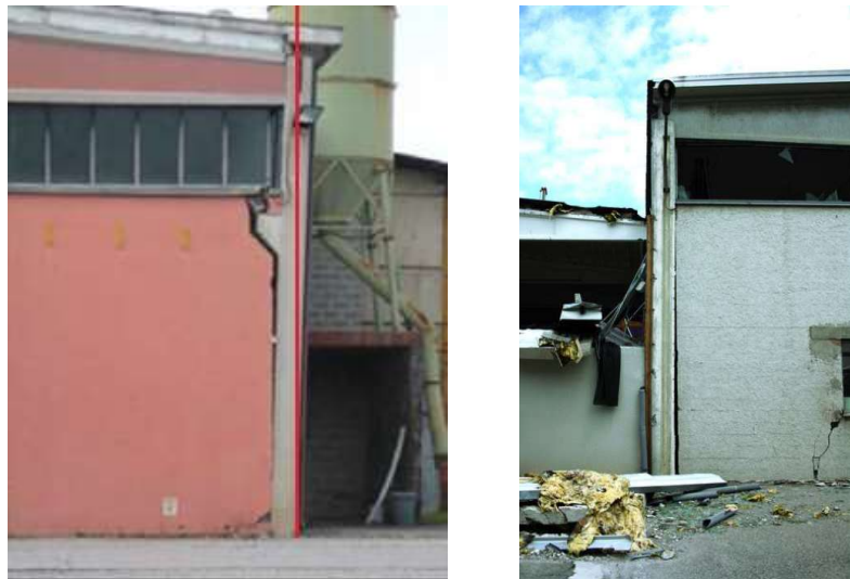
Figura 4 Rotazione residua del pilastro a seguito di un evento sismico [G.L.A.S.C. 2012; A.; Belleri et al. 2015]
