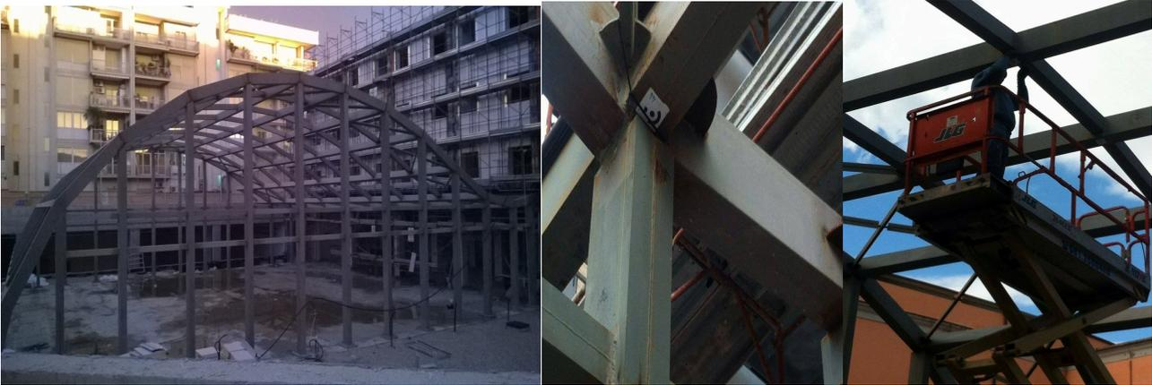
Figura 2 – Struttura (a) e Target posizionati in corrispondenza dei nodi della struttura metallica oggetto di studio (b)
