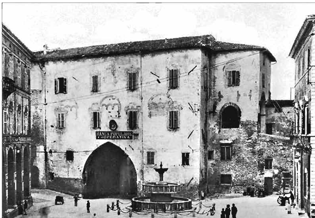
fig. 2 – Fabriano, l'ancien palais du podestat, dans son état antérieur à la restauration des années 1910. Photographie de la fin du XIX e ou du début du XX e siècle provenant de la collection d'A. Venturelli, extraite du site internet dédié à Fabriano administré par P. Latini : http://pinolauni.altervista.org/Fabrianoantica/vecchiafabriano/paginefoto/vecchiopalazzo.htm (page consultée le 15 mai 2019).
