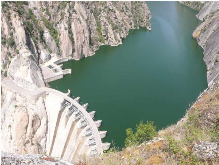
Figura 4. Presa de Aldeadávila, en el Duero. Fuente: Fotografía del autor.
