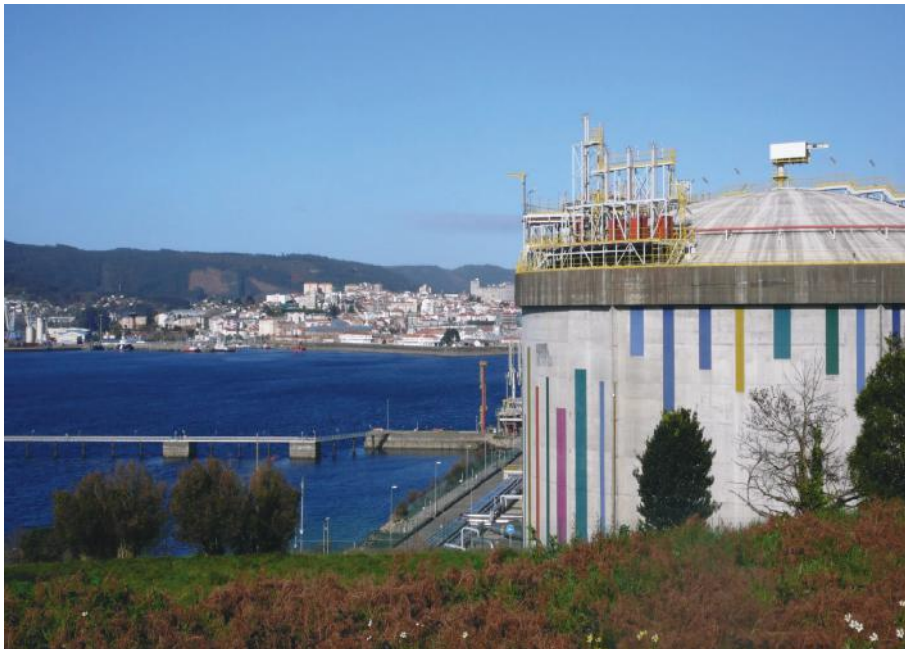
Figura 13. Regasificadora en la Ría de Ferrol. Fuente: Fotografía del autor.
