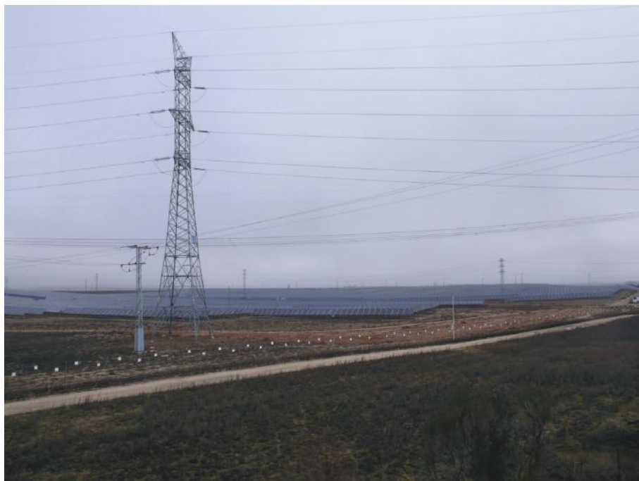
Figura 17. Parque fotovoltaico, próximo a Medina del Campo. Fuente: Fotografía del autor.
