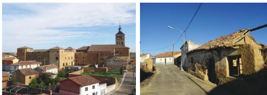
Figura 2. Conjunto palacial (izquierda) y casas populares (derecha) en el barrio de San Pelayo de Grajal de Campos (León, España). Frente a la conservación de los elementos monumentales, se aprecia el abandono y desaparición de las obras humildes, sin las cuales no puede entenderse el propio sistema de este conjunto histórico. Fuente: fotografías del autor.
