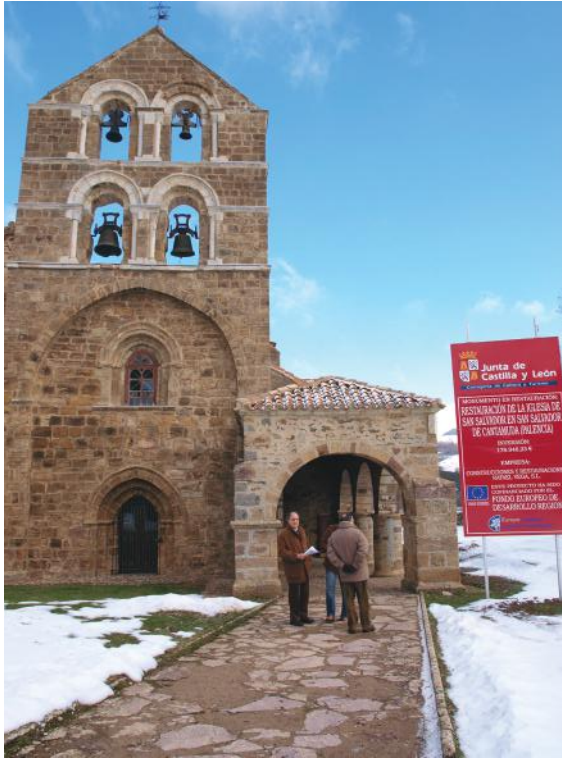
Figura 4. Restauración de la iglesia de San Salvador de Cantamuda, Palencia (2010). Fuente: Junta de Castilla y León.
