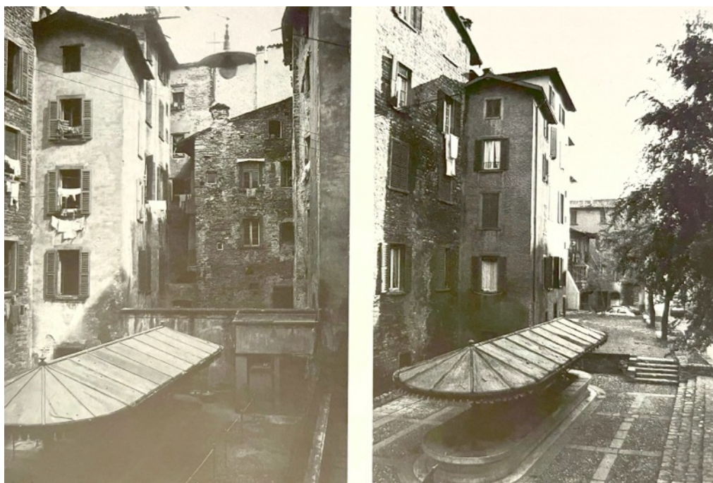
5: Area tra via Mario Lupo e piazza Pendezza prima e dopo le demolizioni [Barbero 1989, 58].
