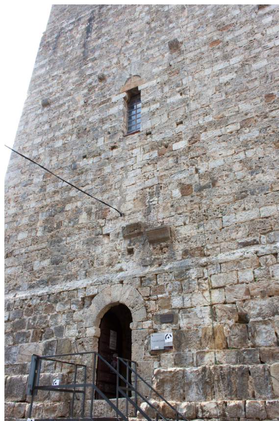
Fig. 4. La fronte meridionale della torre e la porta con la ghiera che risarcisce la rottura nel paramento
