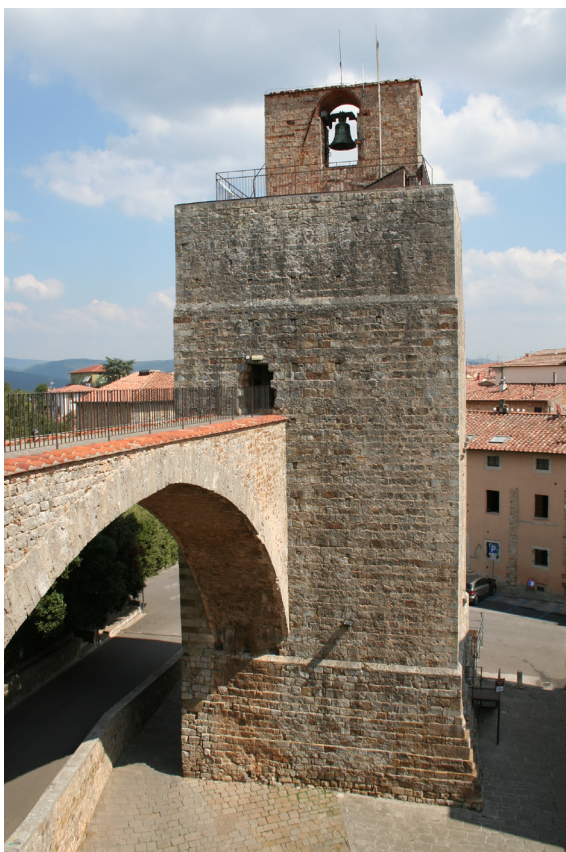
Fig. 2. Massa Marittima, Torre del Candeliere. Fronte occidentale con l'arco di collegamento e l'apertura in rottura di muro.
